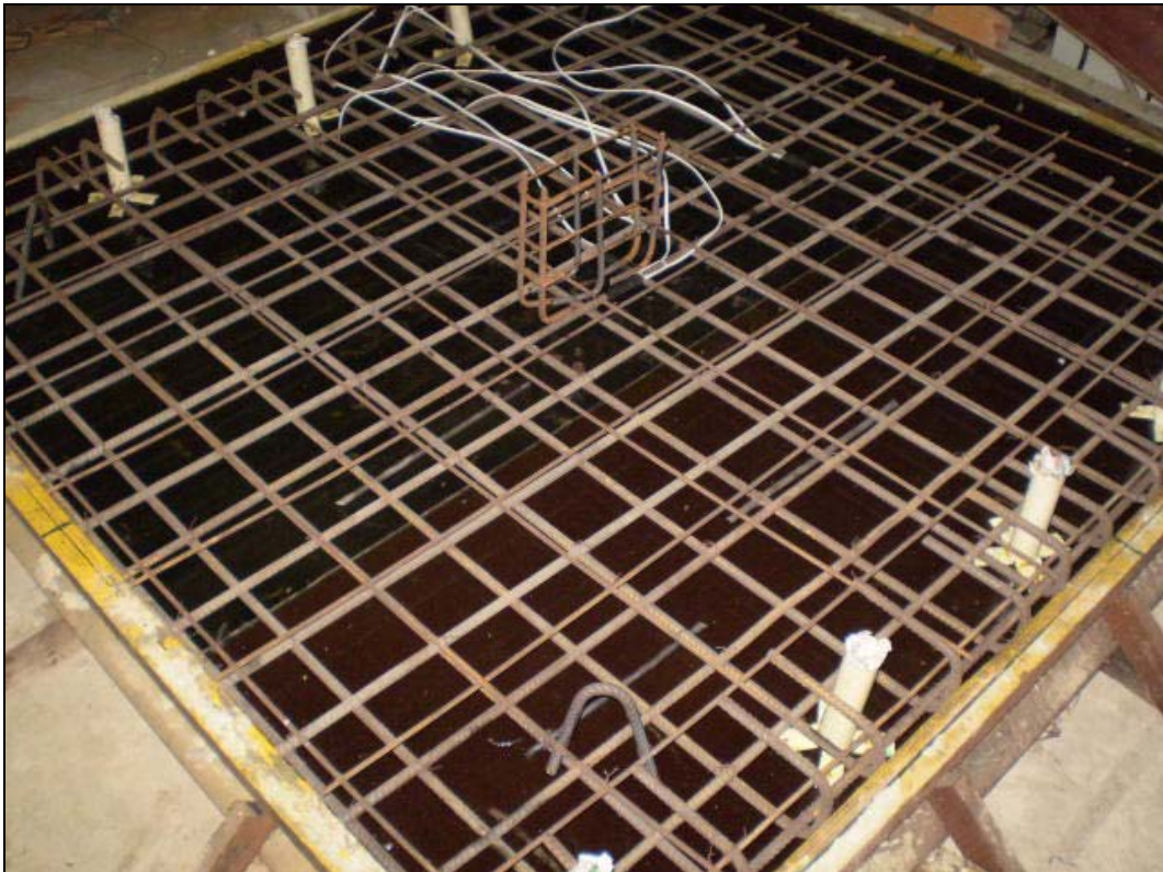
Figura 3.6 – Armaduras da laje L2B posicionada na fôrma
