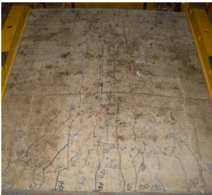
Figura 4.65 – Mapa de fissuração da laje L4A
