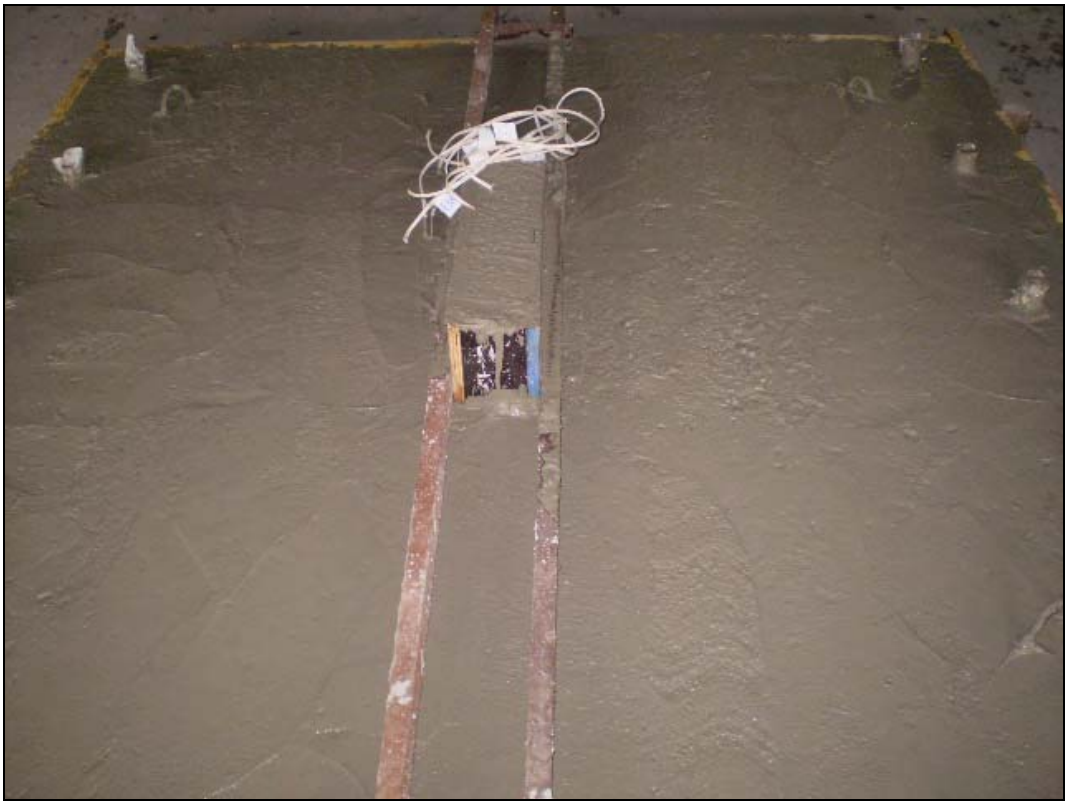
Figura 3.34 – Aspecto da concretagem final das lajes
