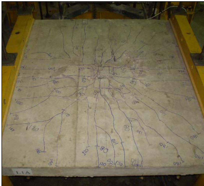
Figura 4.59 – Mapa de fissuração da laje L1A
