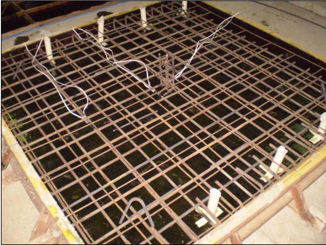
Figura 3.5 – Armaduras da laje L1A posicionada na fôrma
