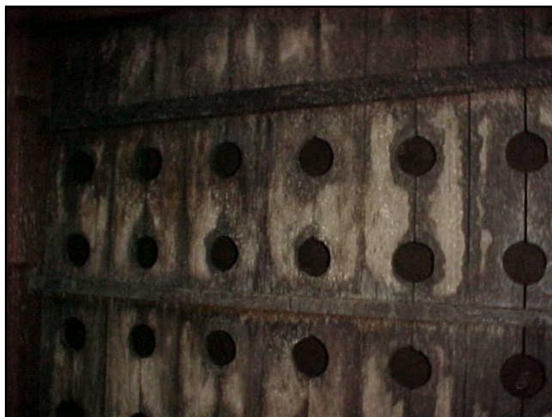
Fotografia 10 – Painel distribuidor de água floculada Fonte: Visita Técnica – ETA Bolonha (2003)
