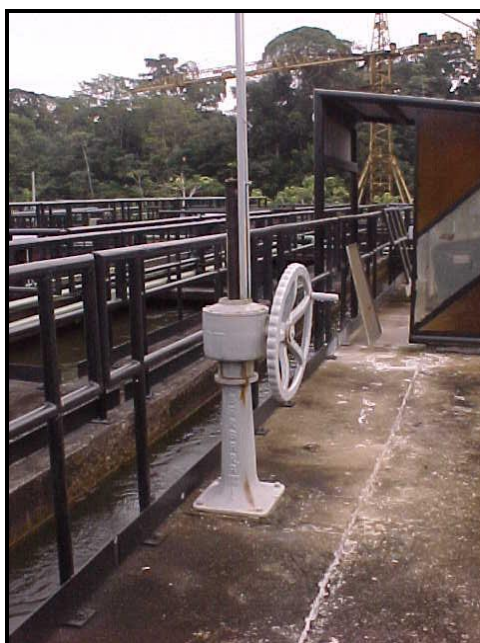
Fotografia 9 – Volante de acionamento da comporta
