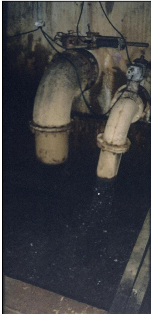
Fotografia 4 – Válvulas de descarga de lodo Fonte: ETA BOLONHA (2003)
