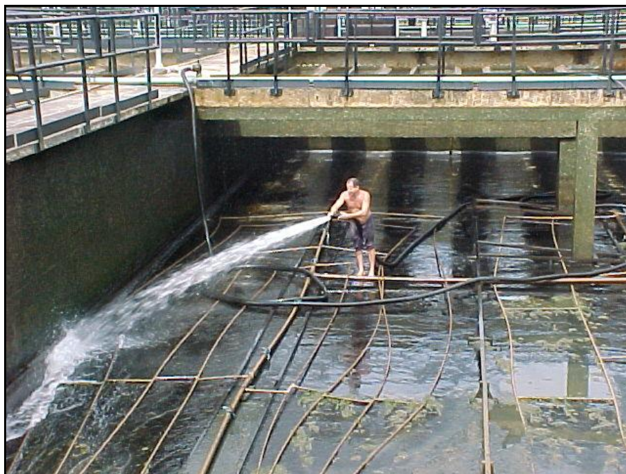
Fotografia 27 - Lavagem do decantador 2 da ETA Bolonha
