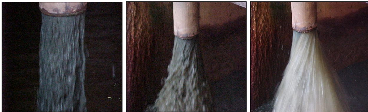
Fotografia 53, 54 e 55 - Descarga do lodo na abertura da válvula de fundo, no 1º e 2º minuto – Fase 3 Fonte: Visita Técnica – ETA Bolonha (2003)
