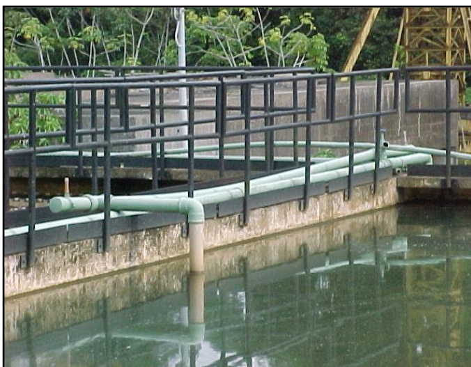
Fotografias 20 e 21 – Tubulação de sinfonamento para remoção do lodo da bandeja intermediária Fonte: Visita Técnica - ETA Bolonha (2003)
