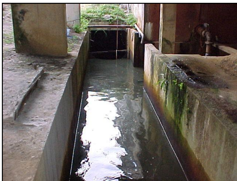
Fotografia 18 – Canal de drenagem do lodo
