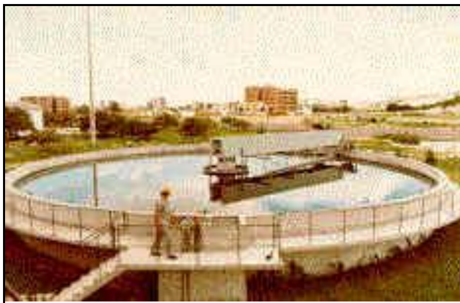
Fotografia 6 - Raspador de lodo do tipo rotativo
