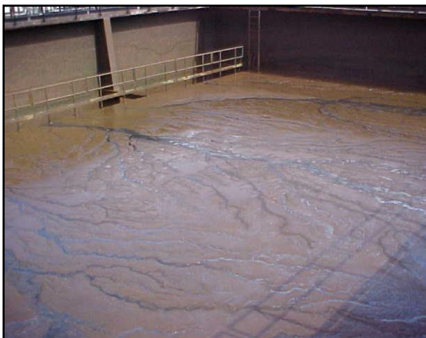
Fotografia 8 – Decantador com bandeja intermediária
