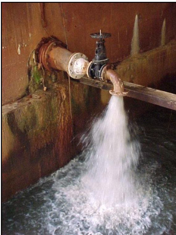
Fotografia 26 - Válvula de descarga de fundo
