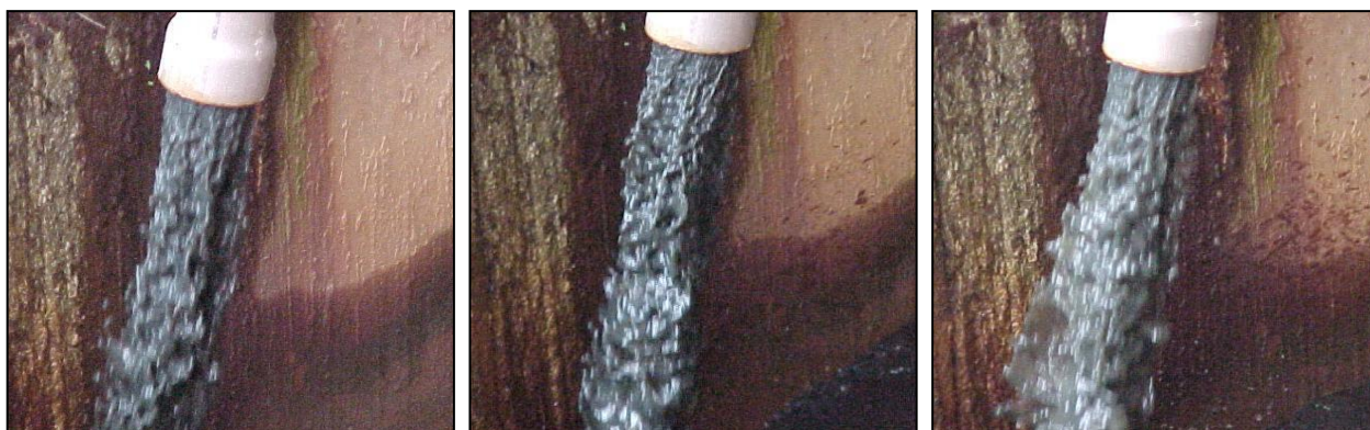
Fotografia 59, 60 e 61 - Descarga do lodo na abertura da válvula do sistema auxiliar, no 5º e 10º minuto – Fase 3 Fonte: Visita Técnica – ETA Bolonha (2003)
