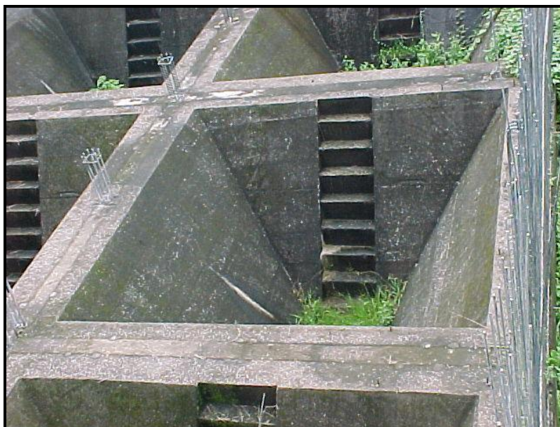
Fotografia 13 – Troncos de pirâmide invertidos do decantador (2ª fase da ETA Bolonha)
