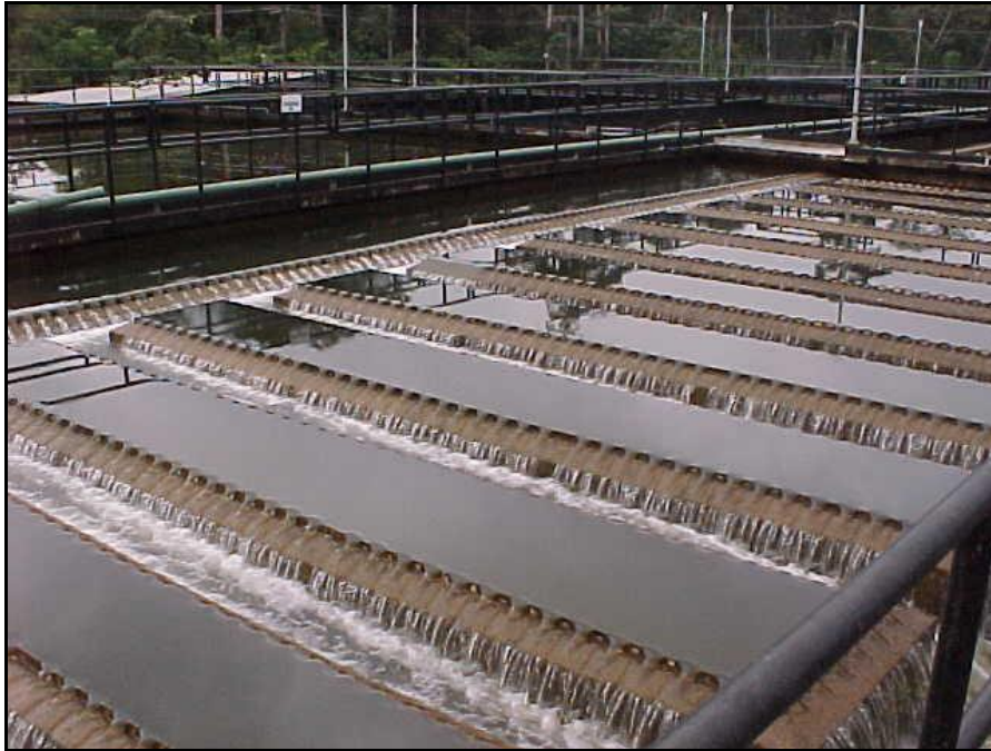
Fotografia 3 – Calhas coletoras de água decantada
