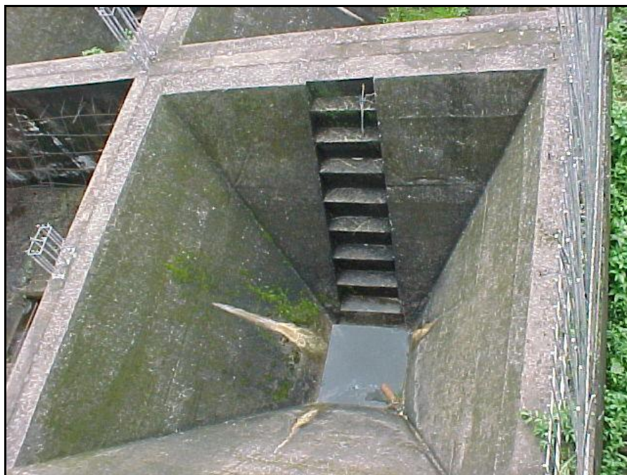
Fotografia 7 - Cones para acumulação do lodo em formato de tronco de pirâmide invertido
