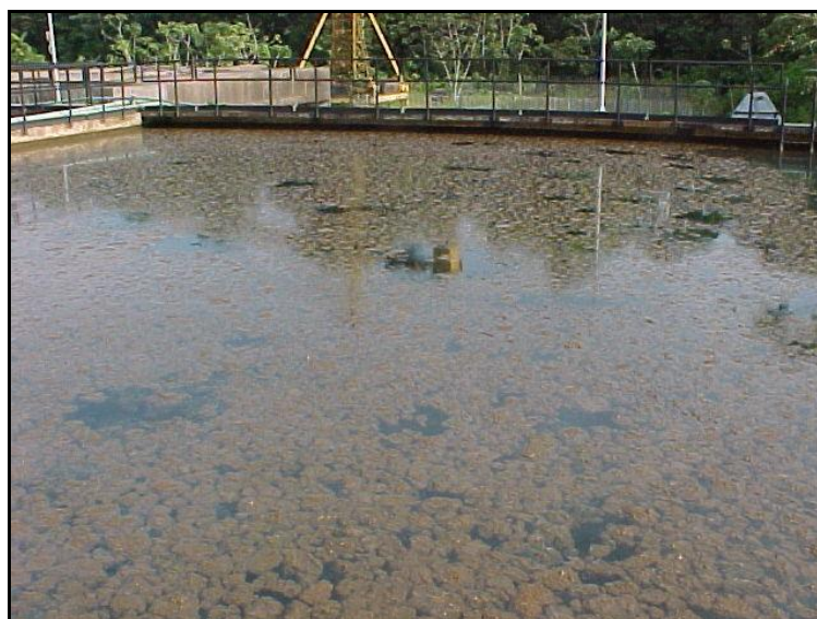
Fotografia 33 - Lodo flotando no decantador 2 (28 dias de operação) na Fase 2
