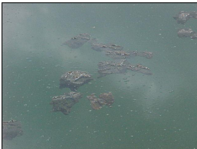
Fotografia 28 - Lodo flutando no decantador 1 (28 dias de operação) na Fase 2 Fonte: Visita Técnica – ETA Bolonha (2003)
