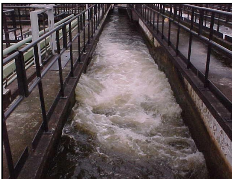
Fotografia 12 – Canal de água decantada
