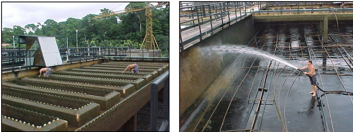
Fotografias 16 e 17 – Lavagem da calha coletora e lavagem interna do decantador
