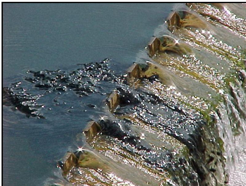
Fotografia 51 - Lodo sendo arrastado para a calha coletora do decantador 1 (19 dias de operação) – Fase 3
