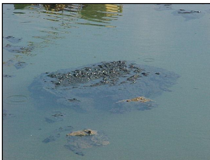
Fotografia 30 - Desprendimento de placas de lodo no decantador 2 (24 dias de operação) na Fase 2 Fonte: Visita Técnica – ETA Bolonha (2003)
