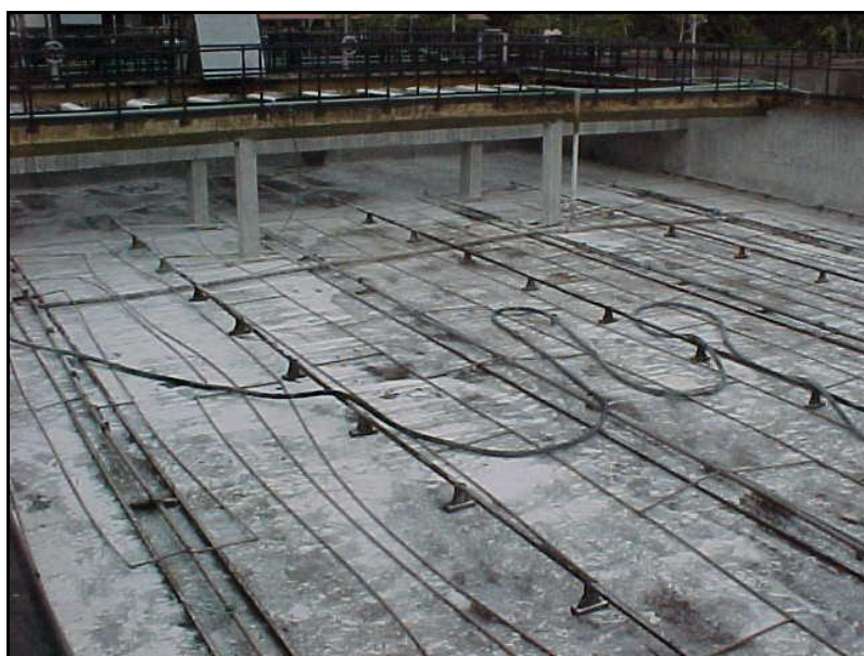
Fotografia 19 – Sistema auxiliar para remoção do lodo
