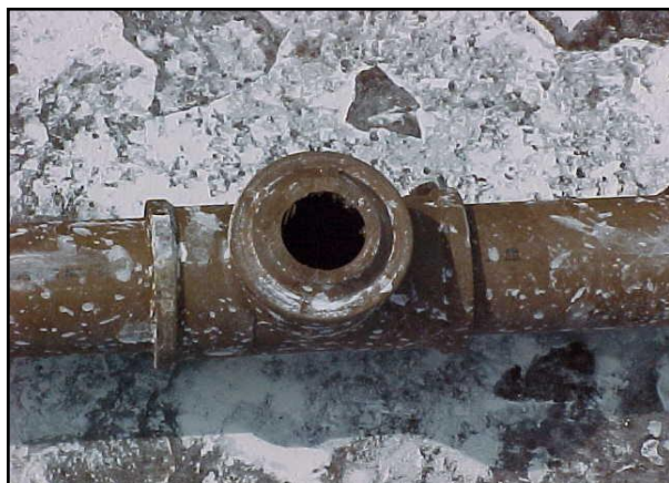
Fotografias 22 e 23 – Bocais de sucção do lodo Fonte: Visita Técnica - ETA Bolonha (2003)
