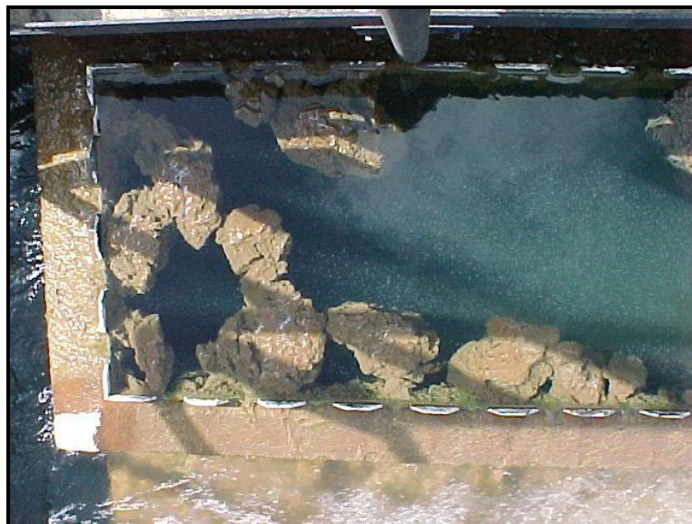
Fotografia 49 - Lodo na calha coletora do decantador 1 (22º dia de operação) – Fase 3 Fonte: Visita Técnica – ETA Bolonha (2003)
