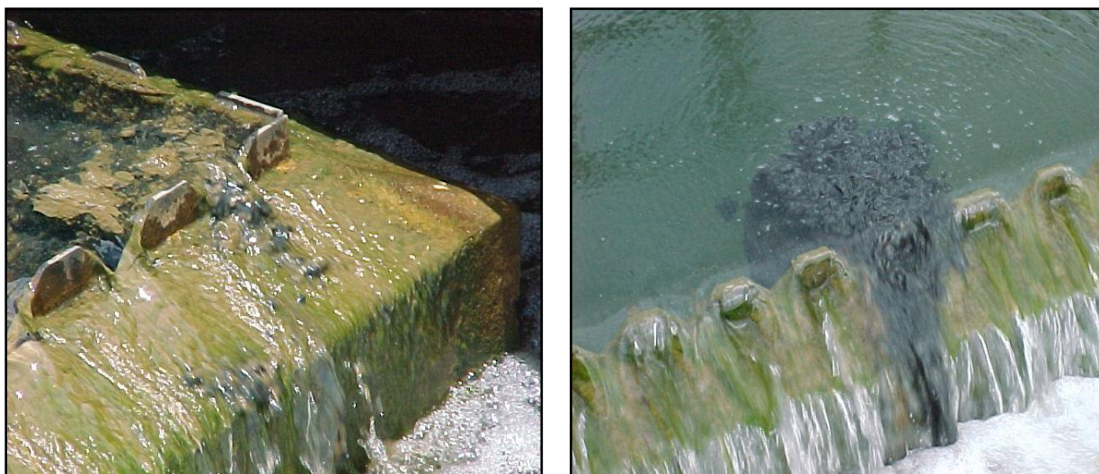
Fotografia 31 e 32 - Lodo arrastados para as calhas coletoras no decantador 2 na Fase 2
