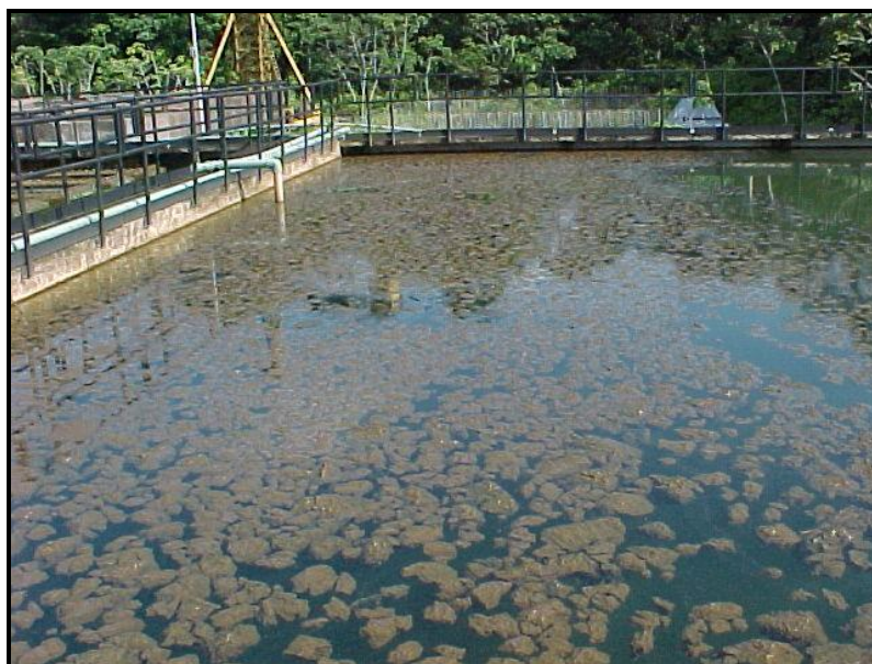
Fotografia 52 - Decantador 1 com a superfície parcialmente coberta de lodo (22 dias de operação) – Fase 3
