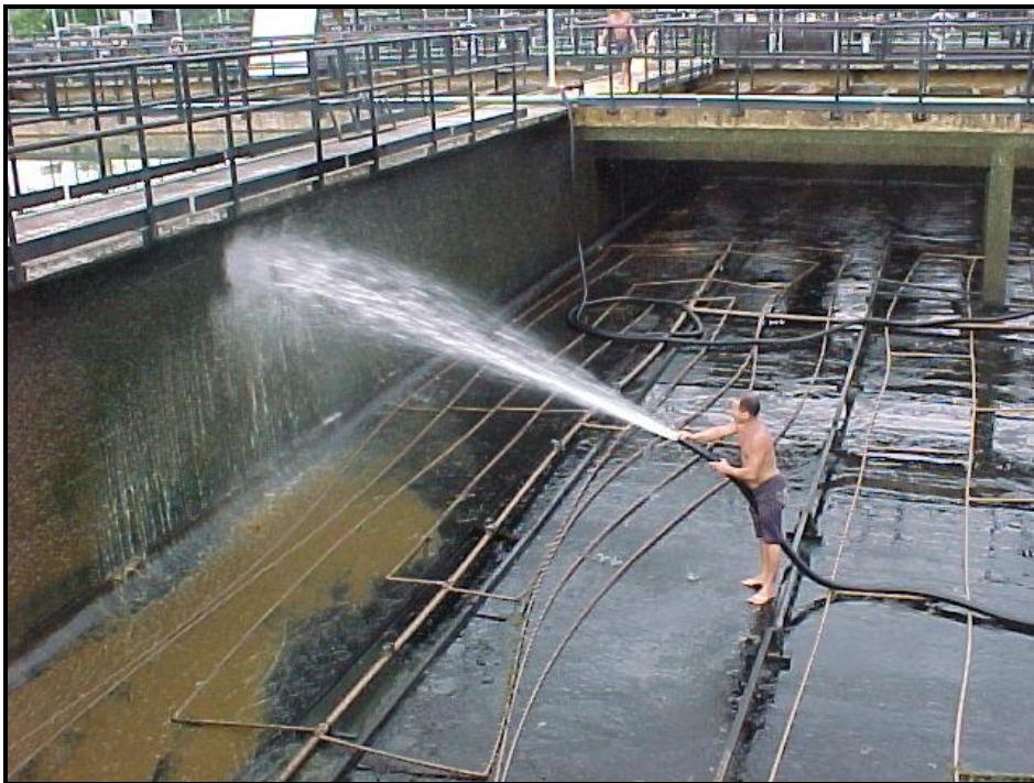
Fotografia 5 – Lavagem do decantador com auxílio de mangueiras de incêndio Fonte: Visita Técnica - ETA BOLONHA (2003)
