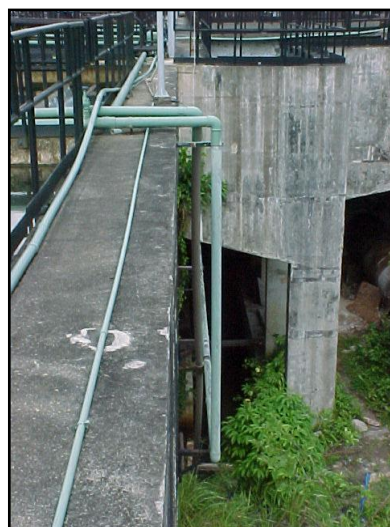
Fotografias 20 e 21 – Tubulação de sinfonamento para remoção do lodo da bandeja intermediária Fonte: Visita Técnica - ETA Bolonha (2003)
