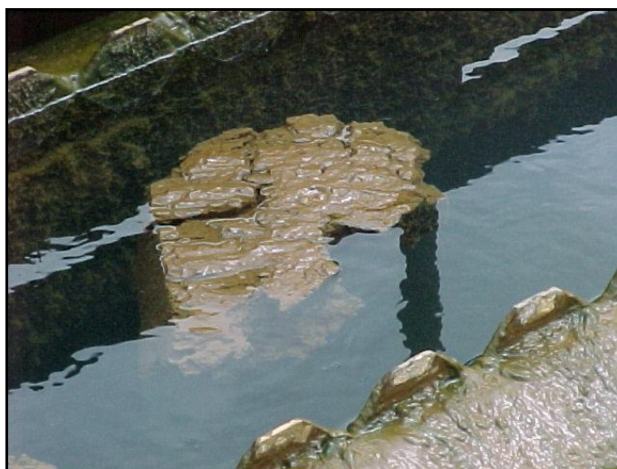
Fotografia 29 - Lodo flutando no decantador 2 (21 dias de operação) na Fase 2 Fonte: Visita Técnica – ETA Bolonha (2003)
