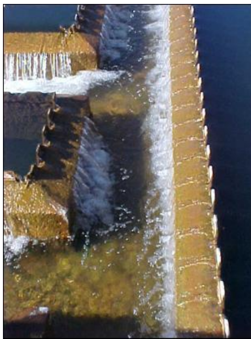
Fotografia 11 – Calhas coletoras
