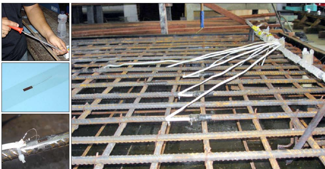
Figura 3.10 – Detalhes do monitoramento das armaduras
