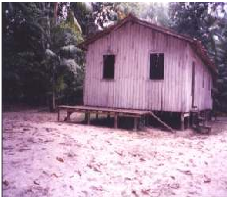
Foto: n° 05 casa coberta com telha Fonte: Euzalina Ferrão, outubro de 2005
