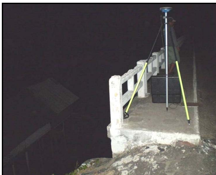
Ponto E28 sob a ponte do rio Sampaio.
