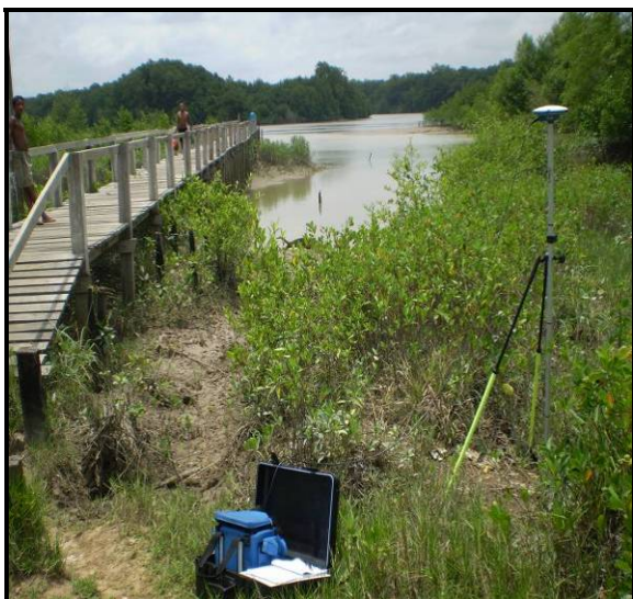
Ponto E06 ao lado da ponte que dá acesso ao rio Caripi.
