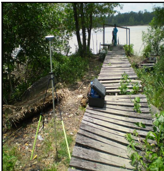
Ponto E03 ao lado da ponte que dá acesso ao rio Maracanã.
