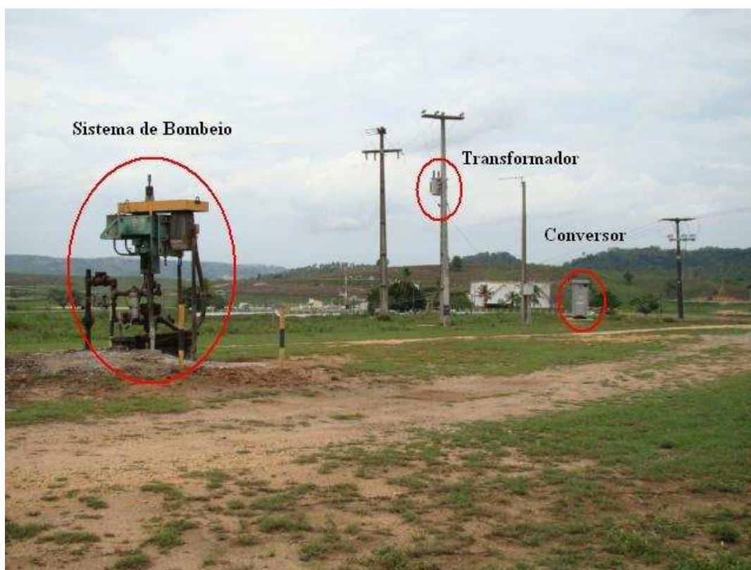
Figura 2.7 – Instalação típica de um poço com BCP
