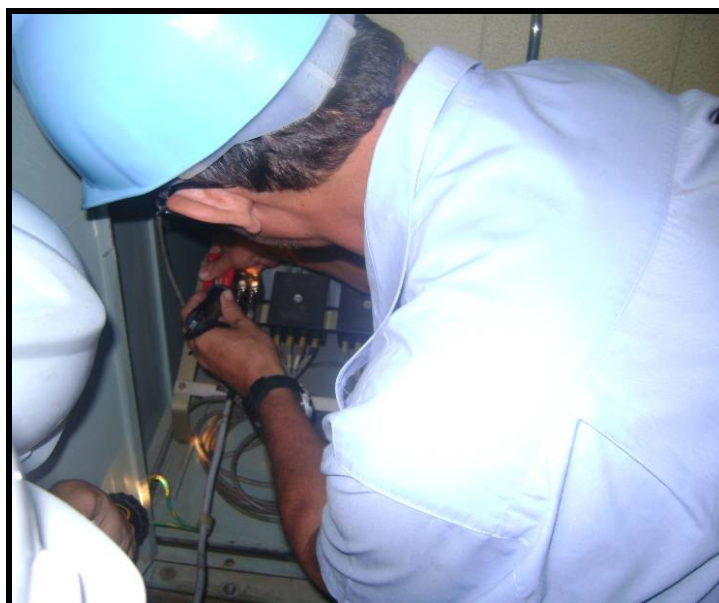
Figura 7.4 – Instalação do transdutor de potência PQVI.
