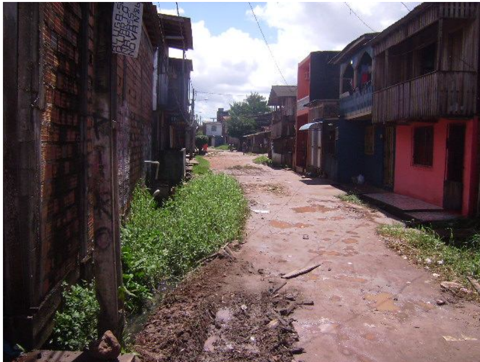
Fotografia 7- Passagem Ligação (Terra Firme).
