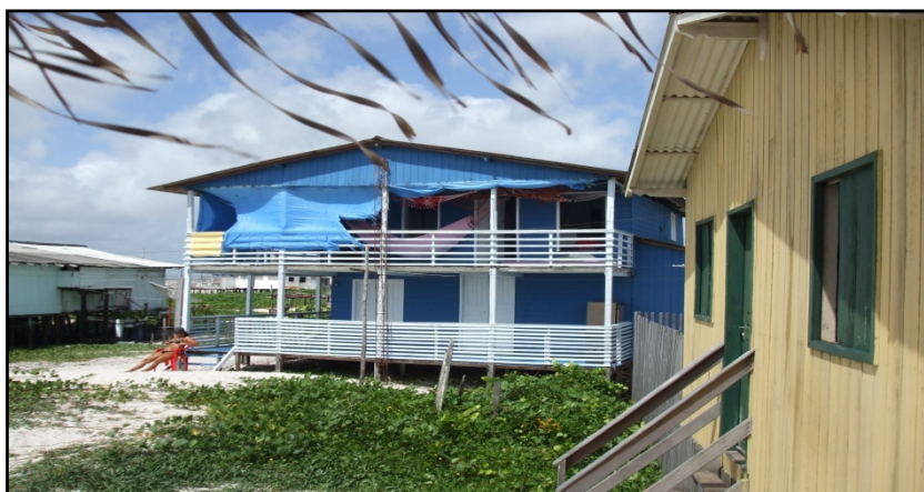
Fotografia 8 – Casas de veraneio na Comunidade costeira Vila dos Pescadores.
