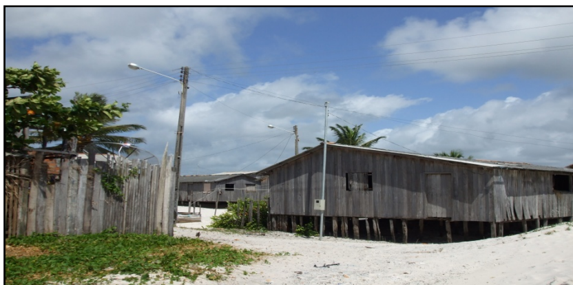
Fotografia 7 – Evidências de processos de erosão na Comunidade costeira Vila dos Pescadores.
