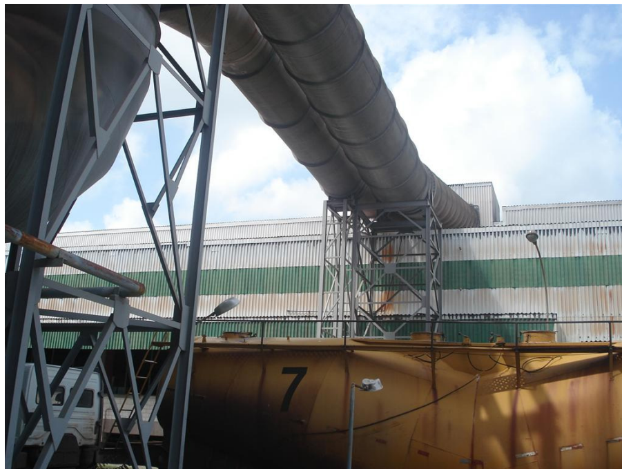
Figura 3.8 – Tubulações que captam gases poluentes
