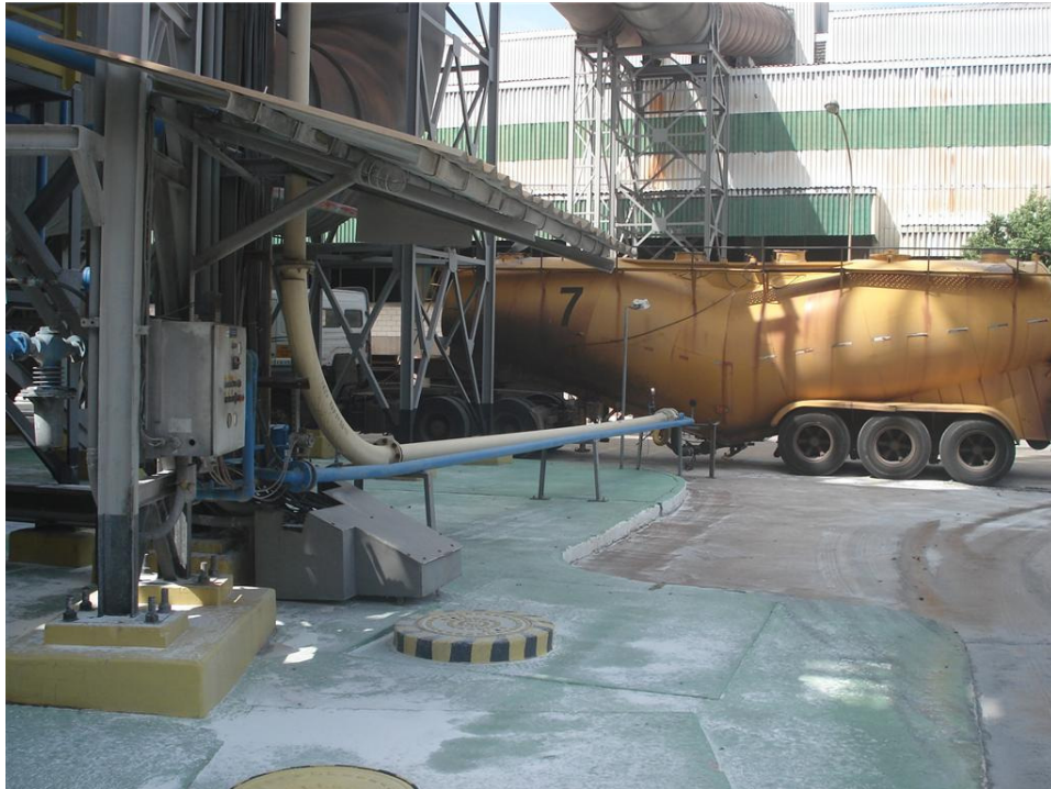
Figura 3.5 – Abastecimento de Silo de Alumina Virgem
