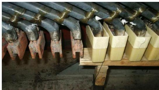
**Figura 3.13** – Foto ilustrando um exemplo de más conexões elétricas
