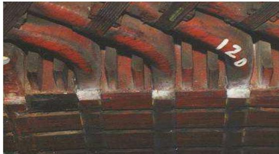
**Figura 3.11** – Foto de uma deterioração da interface de alívio de tensão
