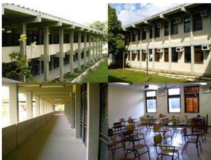
Figura 4.2 – Fotos do pavilhão de salas de aulas.
