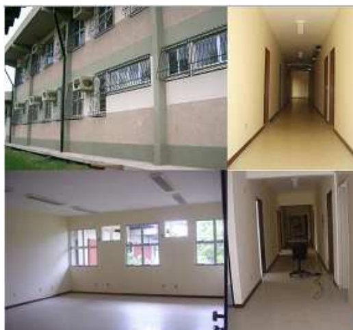
Figura 4.1 – Fotos do prédio anexo.
