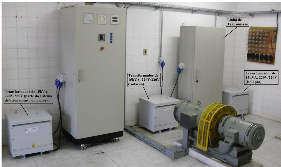
Figura 2.3: Sistema de geração em escala reduzida destacando os transformadores de 15kVA.
