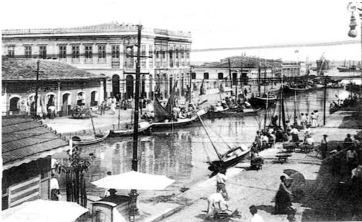
Figura 1 – Canal do Reduto (entre a rua 28 de Setembro e a Praça Magalhães)
