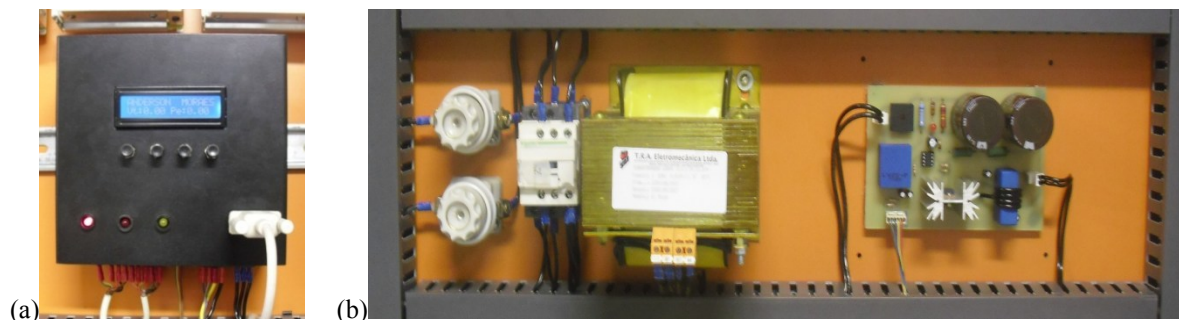
Figura 5.12: (a) Sistema de medição e controle e (b) Circuito atuador.
