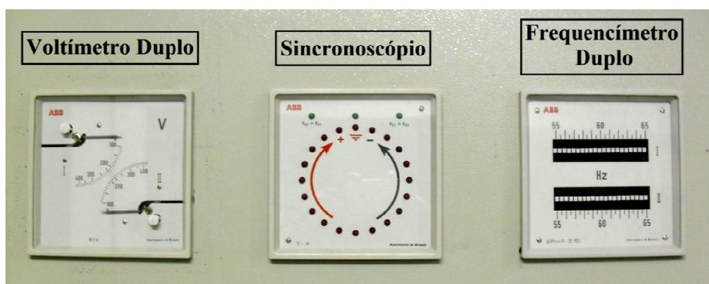
**Figura 7.8: Conjunto de instrumentos para sincronismo do gerador com a rede.**
