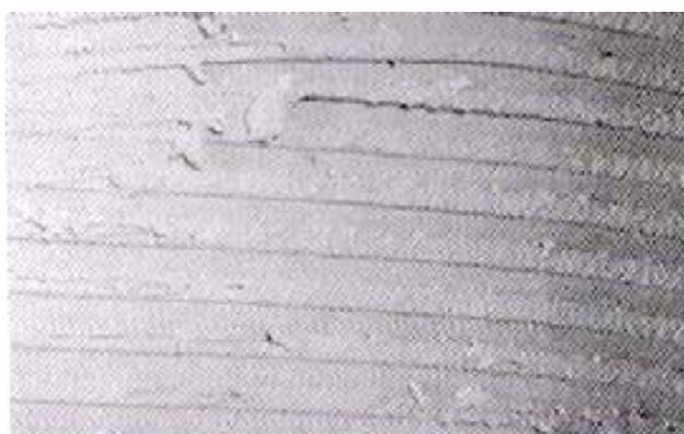
Figura. 2.1 c) Chapisco colante, aplicado com desempenadeira dentada (CEOTTO *et al.*, 2005).
