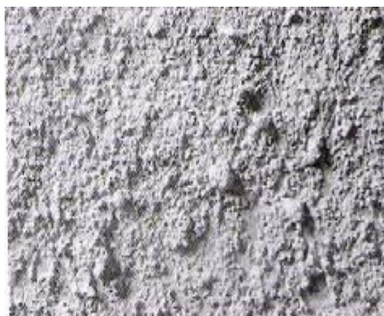
Figura. 2.1 a) Chapisco convencional (cimento, agregado e água), chapado (lançado no substrato com colher de pedreiro (CEOTTO *et al.*, 2005).
