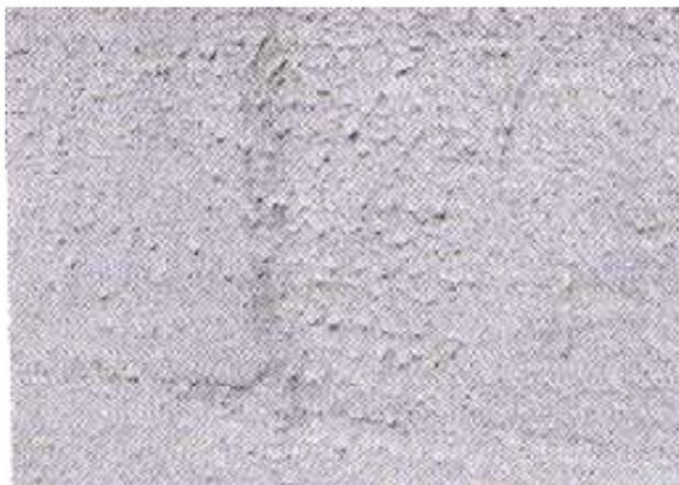
Figura. 2.1 b) Chapisco rolado, aplicado com rolo de espuma (CEOTTO *et al.*, 2005).
