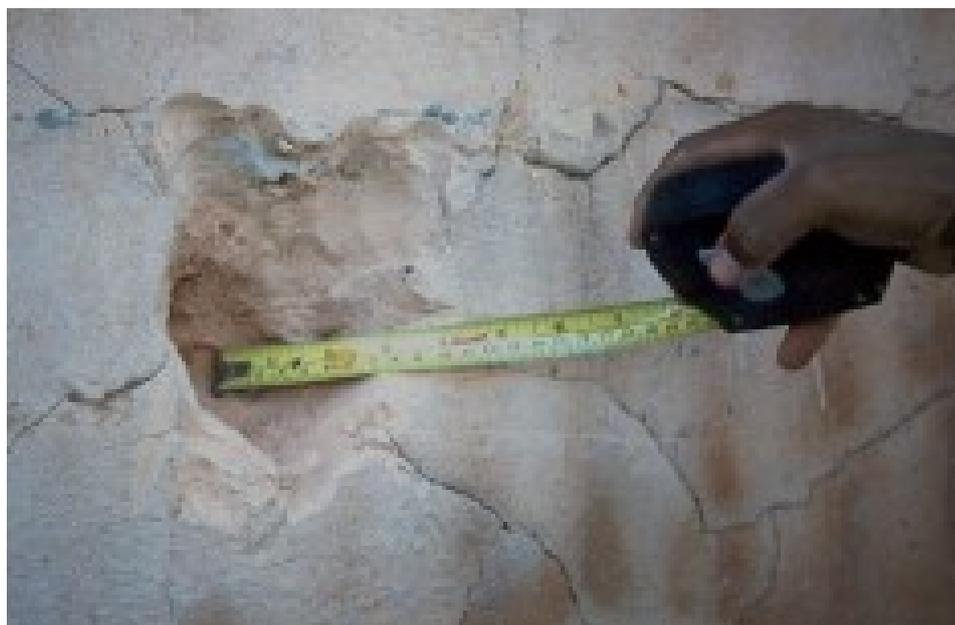
Figura 2.3 – Revestimentos em argamassa, empregados em fachadas, com grandes espessuras (BAUER, 2000).
