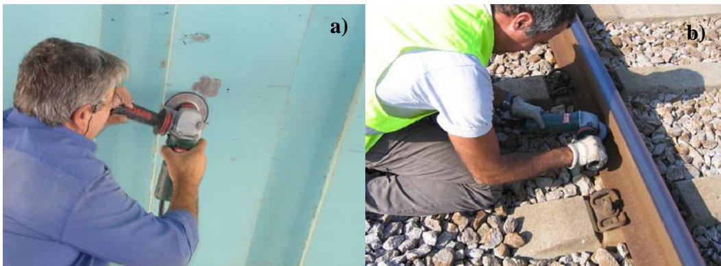
Figura 49 – a) regularização da superfície para instalação dos extensômetros na viga metálica; b) e no trilho (PIMENTEL, 2008)
