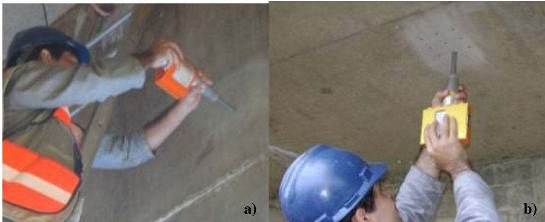
Figura 71 – a) ponto na face interna da longarina onde foi efetuado o ensaio de esclerometria; b) ponto sob a laje onde foi efetuado o ensaio de esclerometria
