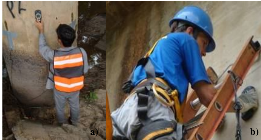
Figura 69 – Ensaio de pacometria: a) no tubulão T7; b) na viga longarina
