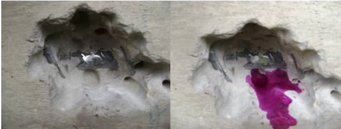
Figura 73 –Aspecto do concreto: a) antes do teste de alcalinidade: b) após o teste de alcalinidade na longarina
