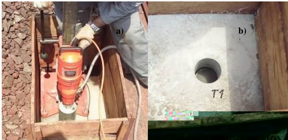
Figura 24 – a) Extração em um ponto do tabuleiro; b) aspecto final de um furo no tabuleiro (TEIXEIRA, 2009)
