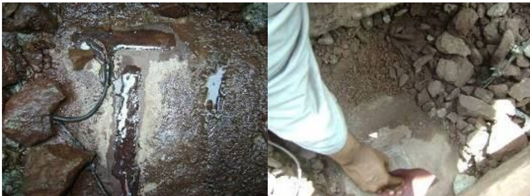
Figura 86 – Extensometria no concreto sobre o tabuleiro no meio do vão
