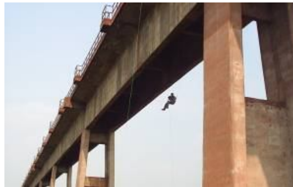
Figura 37 – Sistema de içamento utilizado para instalação dos sensores na longarina (TEIXEIRA, 2009)
