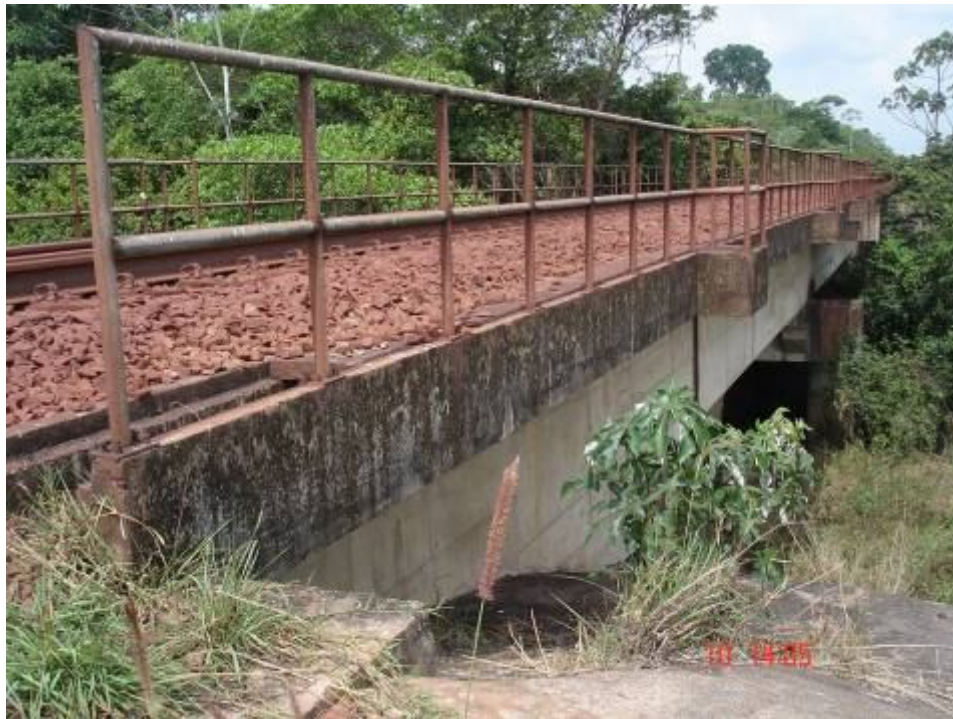
Figura 65 – Ponte sobre o Rio Mãe Maria
