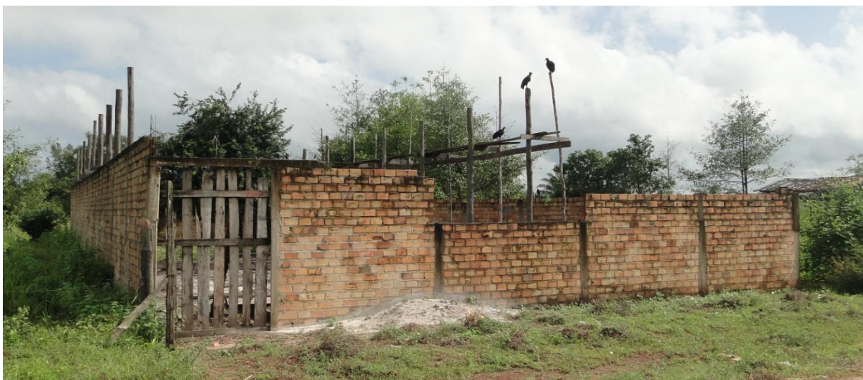
Figura 12: Futuras instalações da Associação coordenada por dona Vânia. Acervo de pesquisa março de 2012.
