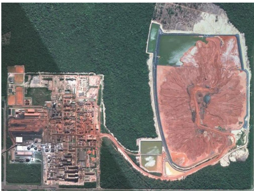
Figura 2.2 – Vista aérea da fábrica da Hydro-ALUNORTE. Fonte: GOOGLE MAPS, 2012.
