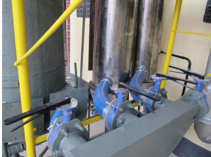
Figura 3.13 – Manifold utilizado para distribuição de gases.
