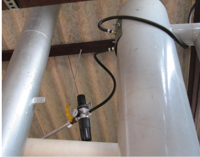
Figura 3.11 – Bico gerador de névoa montado no topo do trocador.
