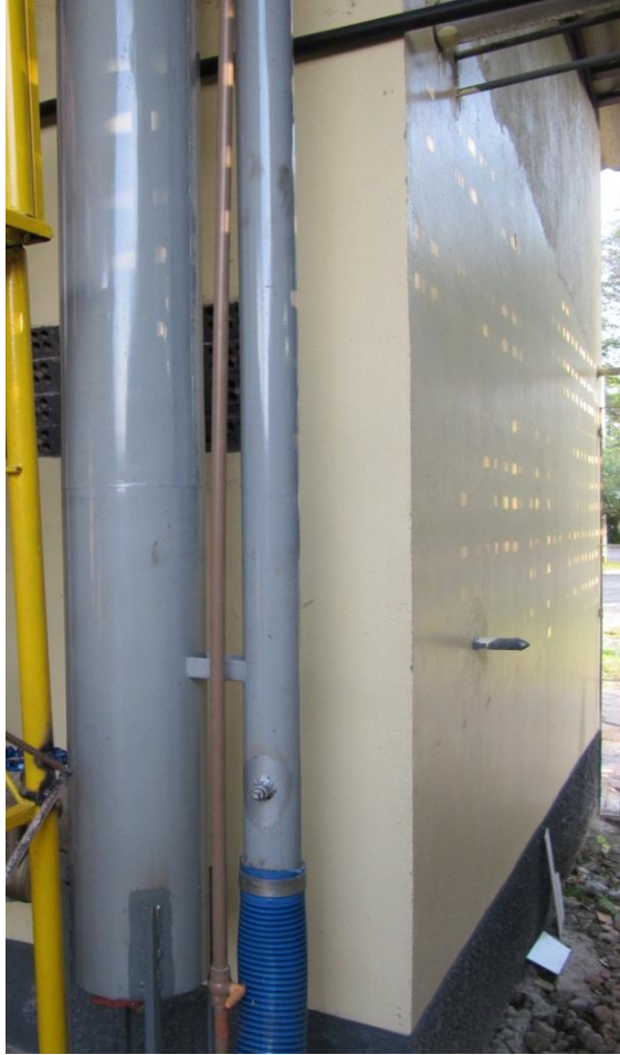
Figura 3.9 – Trocador de calor de contato direto em contracorrente.
