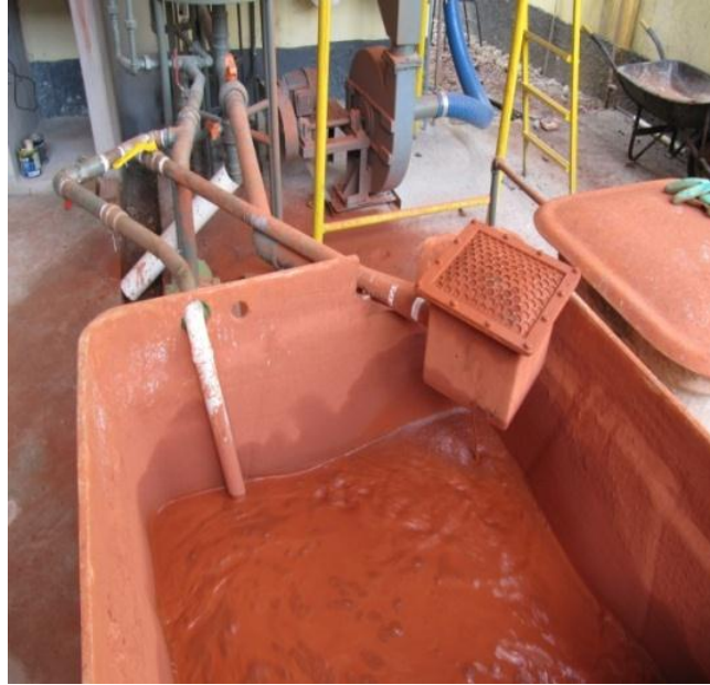
Figura 3.5 – Reservatório destinado à preparação e circulação da suspensão de LV.
