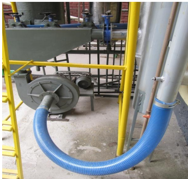
Figura 3.12 – Vista do ventilador ligado ao trocador de calor.
