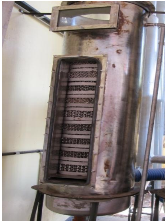
Figura 3.3 – Torre de recheios estruturados.
