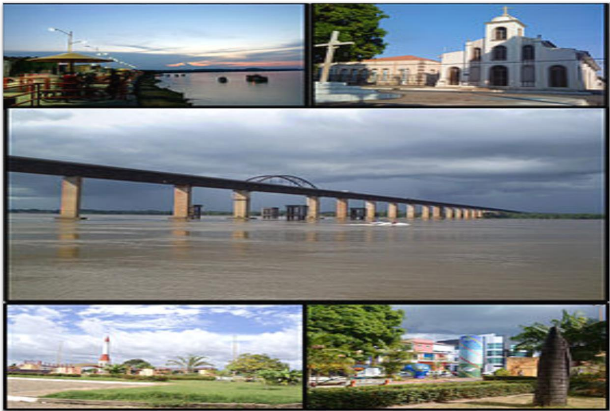
Figura 7: Centro Histórico, construção da ponte sobre o Rio Tocantins e construção da Cidade de Marabá às margens do Rio Itacaiunas. Fonte: INTERNET (2012).
