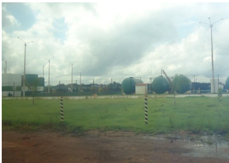
Fotografia 04: Industria no Km 18 Pa 483 Fonte própria.
