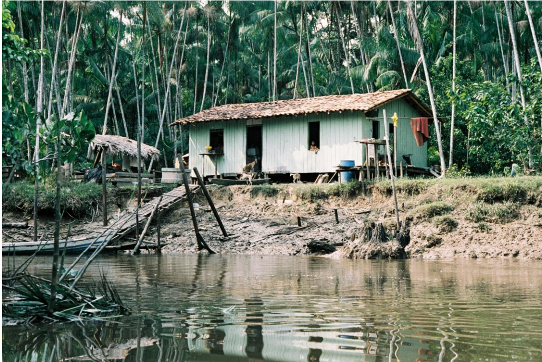
Fotografia 11 - Processo erosivo em terreno na comunidade Beira Rio, na ilha do Combu, Estado do Pará.
