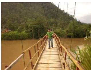
Fotografía 63-Puente colgante a Tundayme.
