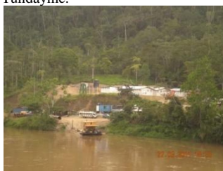
Fotografía 64-Contrucción de puente a Tundayme.
