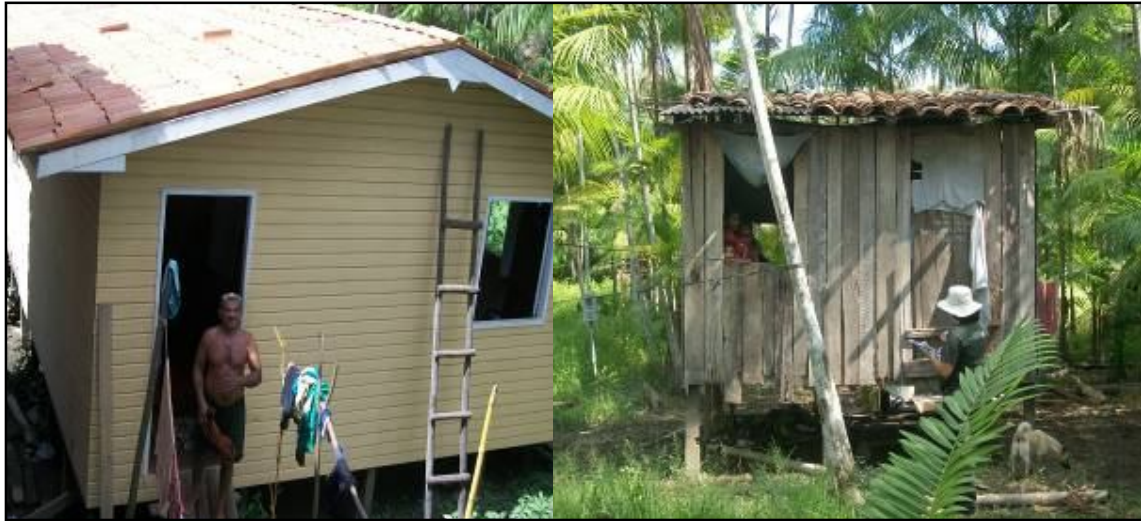
FIGURA 30 – Comparação de infraestrutura das residências das ilhas.
