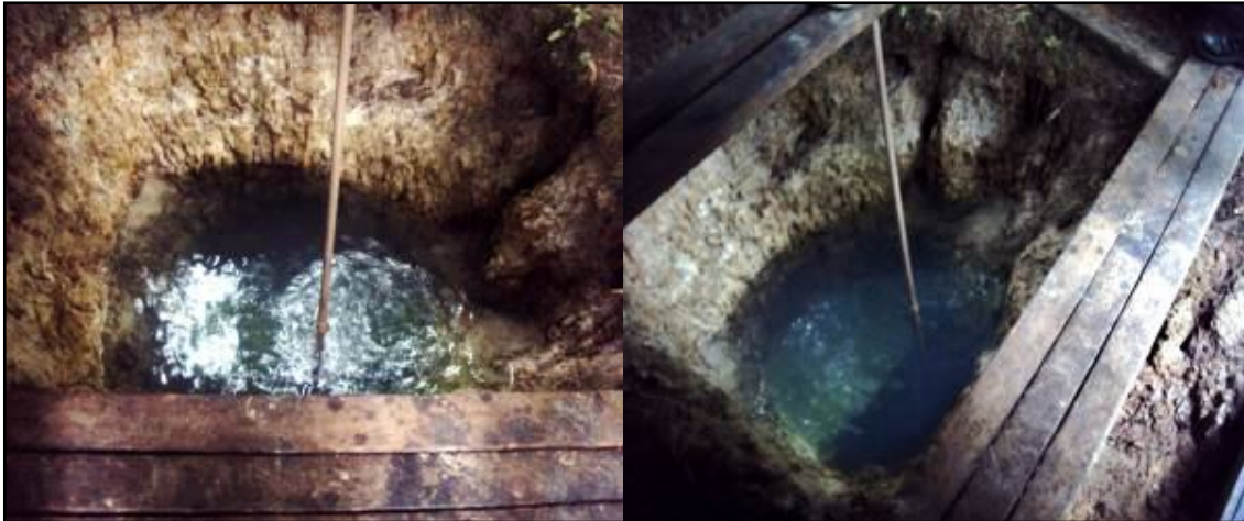
FIGURA 33 – Poço tipo boca aberta ou amazonas sem condições sanitárias existente em terra firme, localizado no município de Acará.
