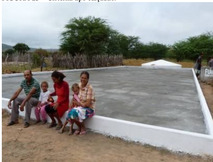
FIGURA 23 – Cisterna tipo calçadão.
