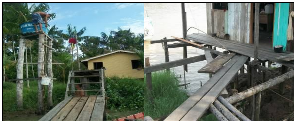
FIGURA 32 – Captação direta do rio manualmente e por sistema de recalque.
