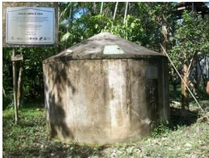
FIGURA 25 – Cisterna na Ilha Grande.
