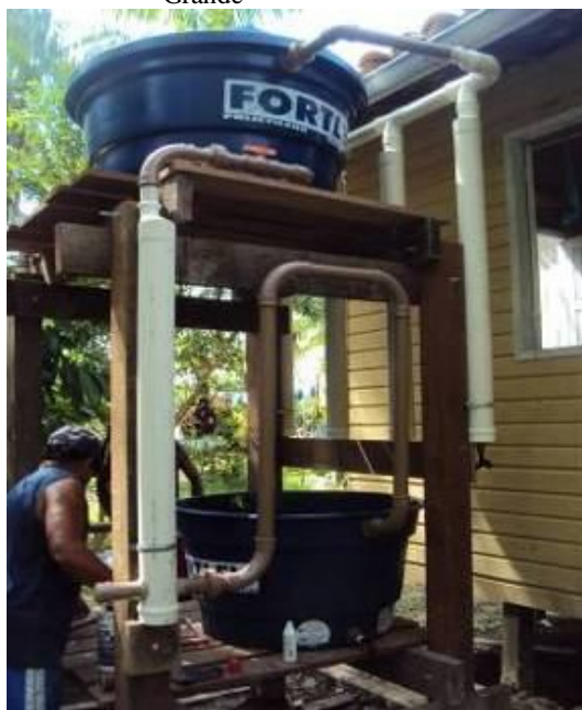
FIGURA 2 – Sistema de Aproveitamento da Água da Chuva instalado na ilha Grande
