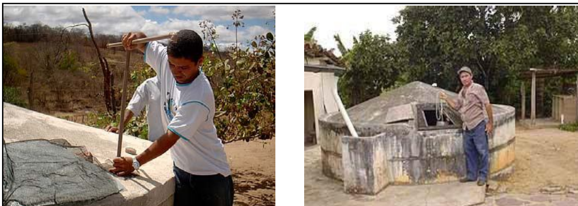
FIGURA 17 – Bombeamento manual e retirada com balde.
