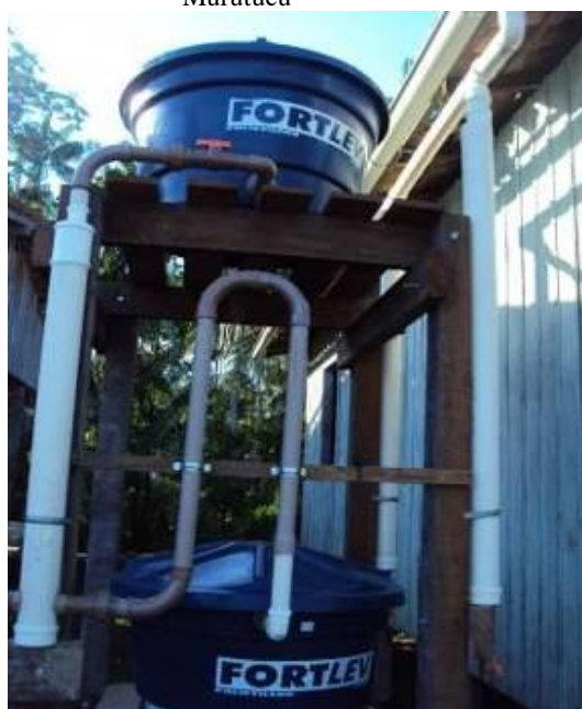
FIGURA 3 – Sistema de Aproveitamento da Água da Chuva instalado na ilha Murutucu
