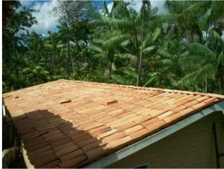
FIGURA 34 – Telhado de uma casa padrão INCRA.
