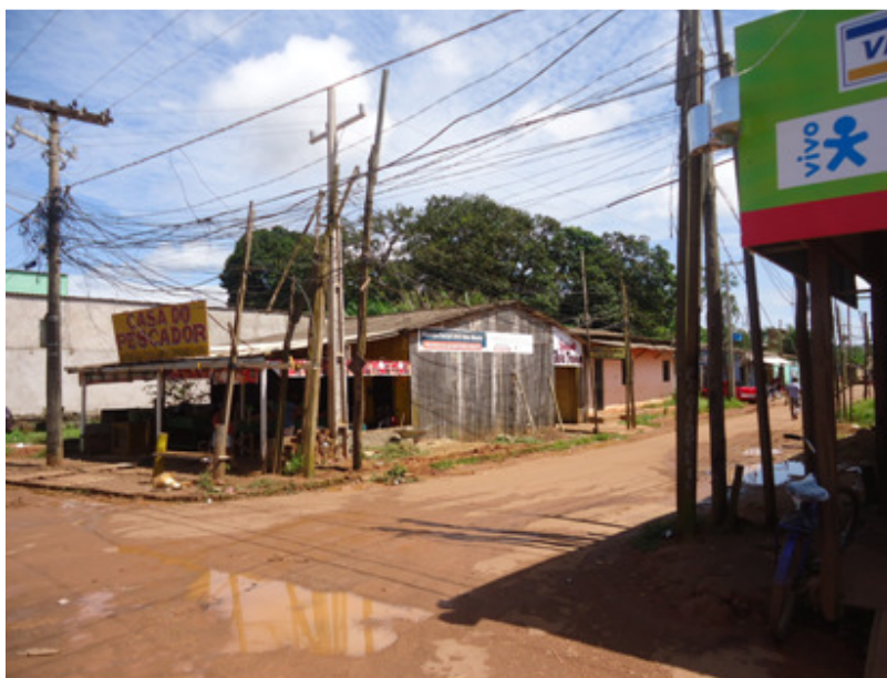
FOTOGRAFIA 4: Rede de Distribuição de Energia no Bairro Baixão do Tufi
