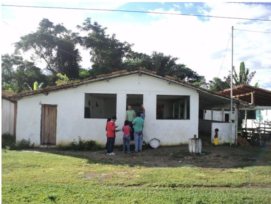
Foto 18: Prédio da igreja local utilizado como sala de aula da E. M. E. F. Sauá Grande. Fonte: Pesquisa de Campo, 2011.
