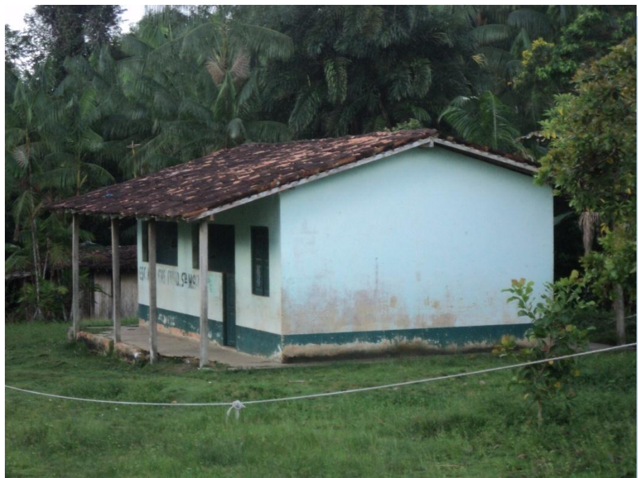
Foto 15: Faixada do prédio de alvenaria da E. M. E. F. Santa Maria III. Fonte: Pesquisa de Campo, 2011.
