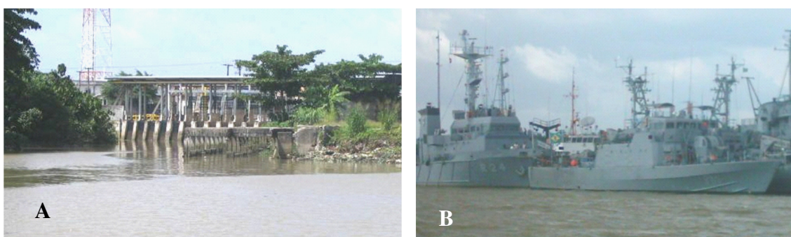
Figura 4 - Estação Canal do Jacaré. (A) Canal do Una; (B) Área de Abastecimento de combustível.
