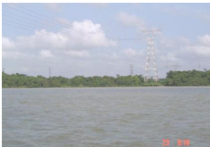
Figura 7 - Estação Linhão do Tucuruí
