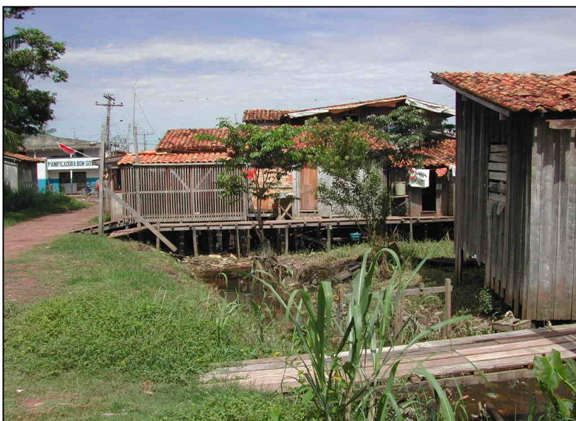
FOTO 02: Residências Construídas Sobre os Canais no Bairro de São João. Os fatores como renda familiar e baixa valorização dos terrenos próximos a áreas alagadas favoreceram a ocupação dessa porção da cidade (Fonte: Cledson N Alves, 10/02/ 05).
