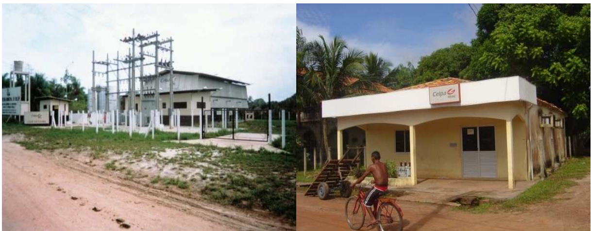
Fotografia 25: Vista frontal da usina de geração de energia termo-diesel em Cotijuba
