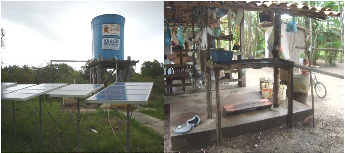
Fotografia 29: Sistema de abastecimento de água do Poção em 2004 com sua infraestrutura completa. Atualmente as células de silício foram retiradas não se sabe afirmar se pela UFPA ou por vândalos
