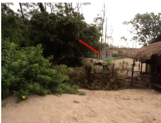
Figura 20. Empreendimento e banheiro público construído sobre as dunas na praia da Barra Velha, Soure. Fonte: Eliane Santana, 2011.
