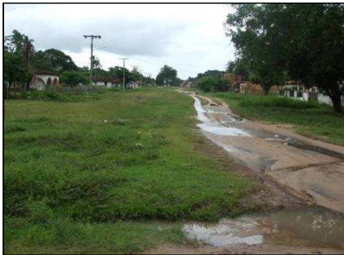
Figura 13. Rua afastada do núcleo urbano do Município de Soure.
