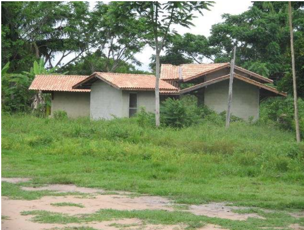
Figura 03. Instalações que servirão para o funcionamento do Posto de Saúde Indígena (inauguração prevista para o início de 2008). Praia do Mangue. Foto: Diogo Rego.
