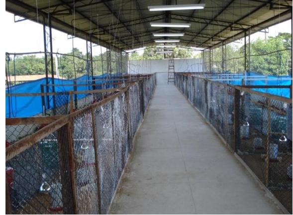
Figura 2- Vista interna do galpão
