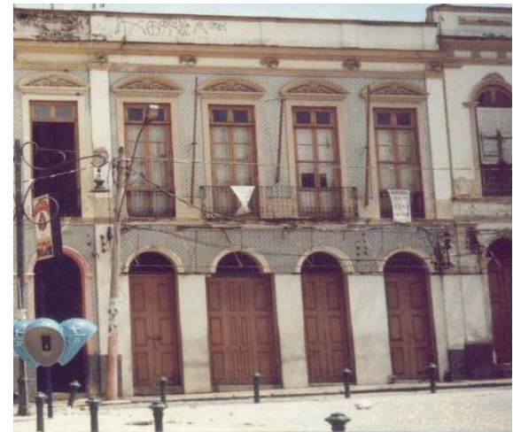
Fig. 77: Vista do imóvel em 2001. Fonte: INBISU-IPHAN. Belém, 2001.
