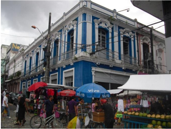
Fig. 98: Edificação na Rua Santo Antônio, nº. 158 (loja de produtos estéticos, sem identificação visual na fachada). Fonte: Borges, Tatiana, 2012.
