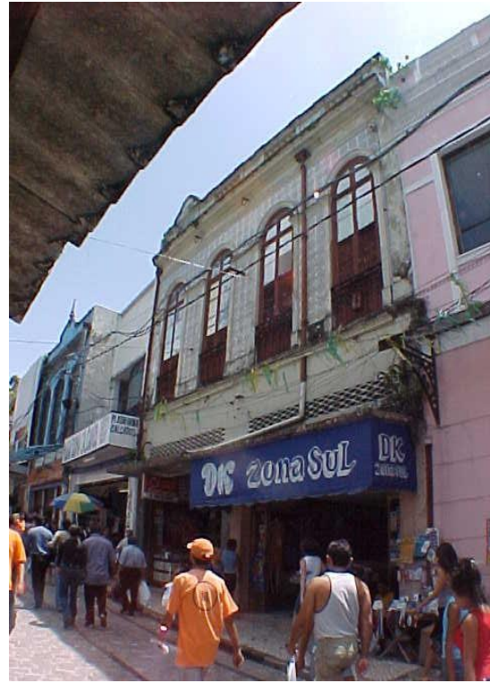
Fig. 95: Vista do imóvel em 2001. Fonte: INBISU-IPHAN. Belém, 2001.
