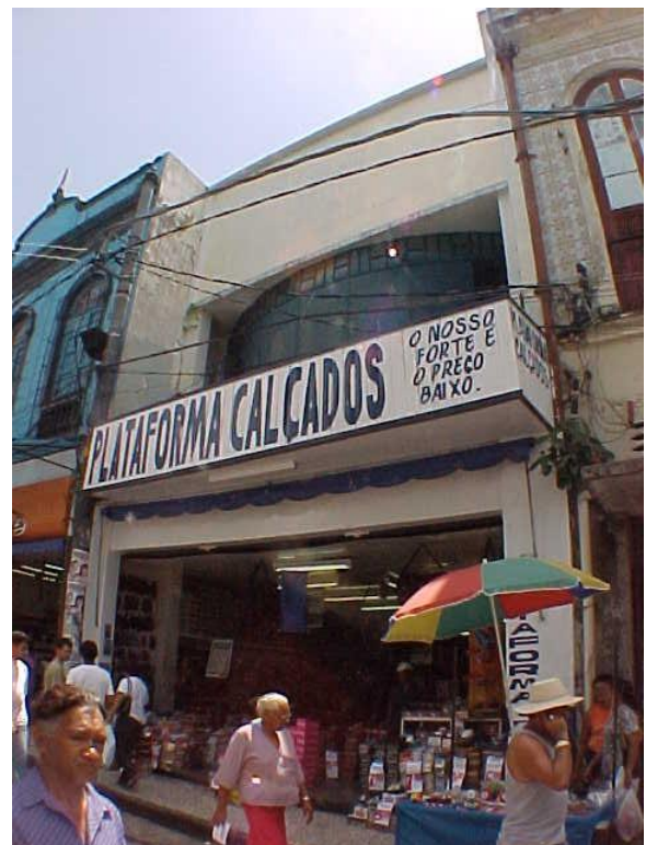
Fig. 93: Vista do imóvel em 2001. Fonte: INBISU-IPHAN. Belém, 2001.
