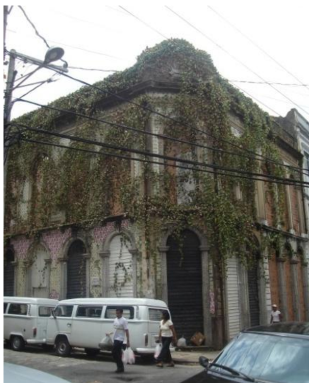
Fig. 117: Imóvel que seria restaurado, na Rua Leão XIII. Fonte: Acervo DPHAC/SECULT.
