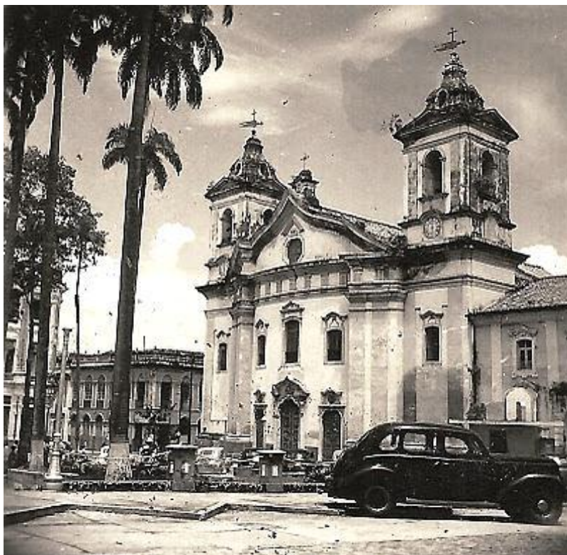
Fig. 32: Vista da Igreja das Mercês.
