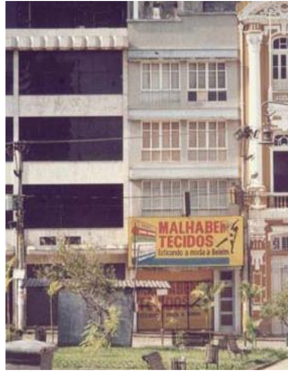
Fig. 103: Vista do imóvel em 2001. Fonte: INBISU-IPHAN. Belém, 2001.
