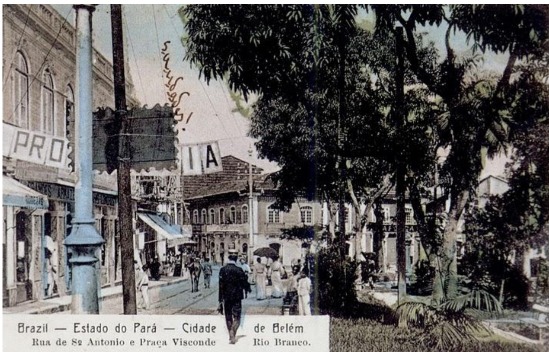
Fig. 22: Outra vista da Rua Santo Antônio, agora a partir da Tv. Barão do Rio Branco. Detalhe da vasta vegetação da praça.
