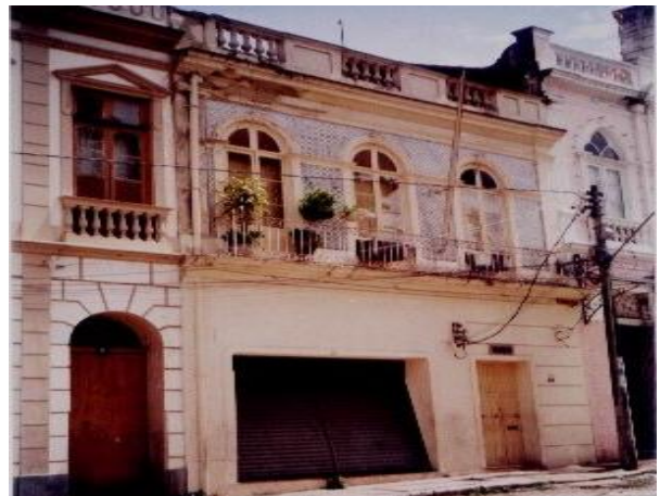
Fig. 83: Vista do imóvel em 2001. Fonte: INBISU-IPHAN. Belém, 2001.
