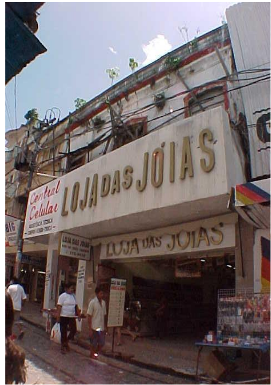
Fig. 87: Vista do imóvel em 2001. Fonte: INBISU-IPHAN, Belém, 2001.
