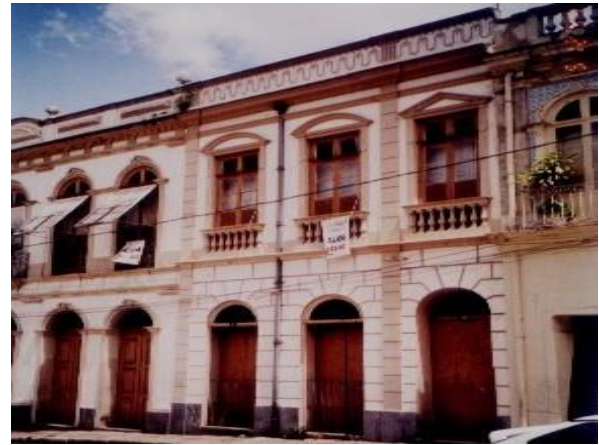
Fig. 81: Vista do imóvel em 2001. Fonte: INBISU-IPHAN. Belém, 2001.
