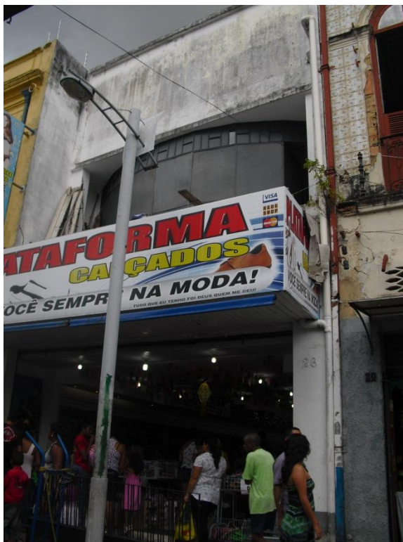
Fig. 92: Edificação na Rua Santo Antônio, n.º. 26 (Loja Plataforma Calçados). Fonte: Borges, Tatiana, 2012.
