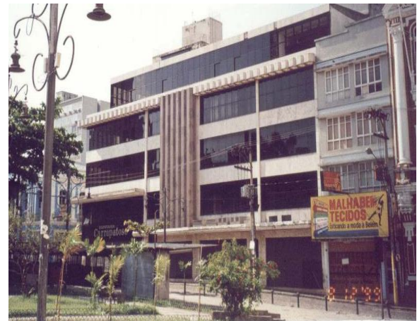
Fig. 101: Vista do imóvel em 2001. Fonte: INBISU-IPHAN. Belém, 2001.
