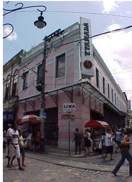
Fig. 97: Vista do imóvel em 2001. Fonte: INBISU-IPHAN. Belém, 2001.
