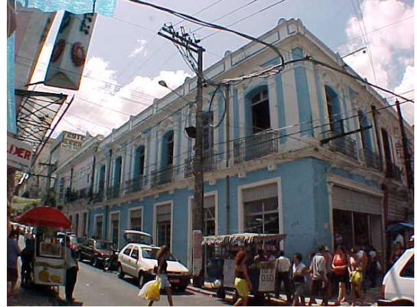
Fig. 99: Vista do imóvel em 2001. Fonte: INBISU-IPHAN. Belém, 2001.
