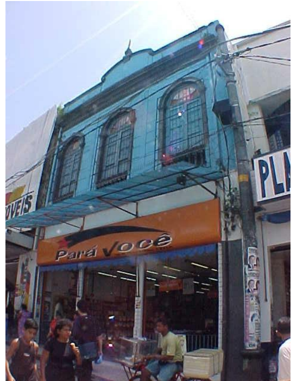
Fig. 91: Vista do imóvel em 2001. Fonte: INBISU-IPHAN. Belém, 2001.
