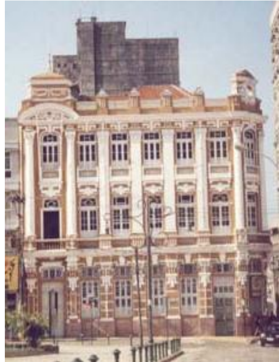
Fig. 105: Vista do imóvel em 2001. Fonte: INBISU-IPHAN. Belém, 2001.
