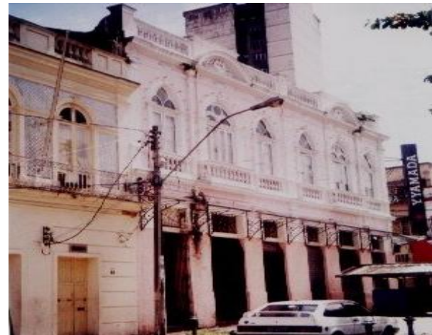
Fig. 85: Vista do imóvel em 2001. Fonte: INBISU-IPHAN. Belém, 2001.
