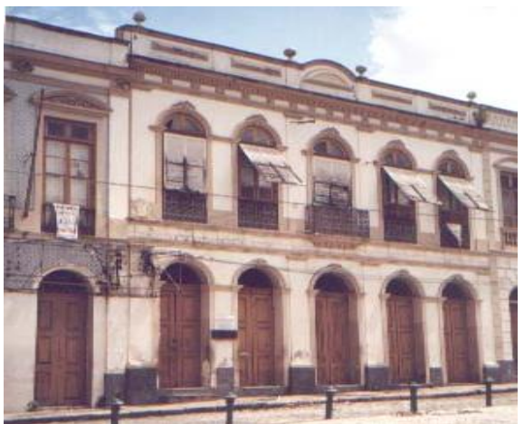
Fig. 79: Vista do imóvel em 2001. Fonte: INBISU-IPHAN. Belém, 2001.
