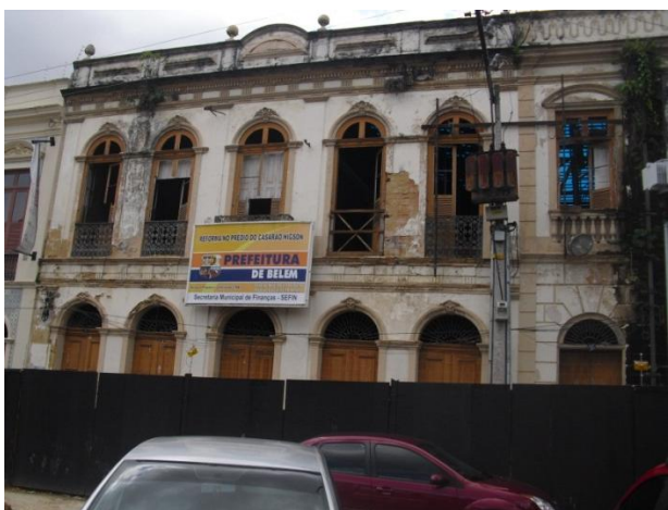
Fig. 78: Edificação na TV. Barão do Rio Branco, nºs. 23/33. Em obras, para abrigar dependências da SEFIN. Fonte: Borges, Tatiana, 2012.
