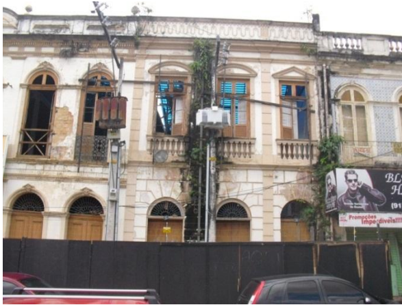
Fig. 80: Edificação na Tv. Barão do Rio Branco, nº. 37 (SEFIN). Fonte: Borges, Tatiana, 2012.
