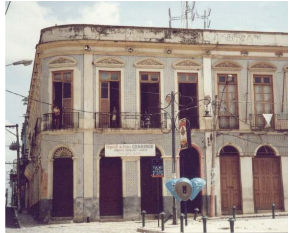
Fig. 75: Vista do imóvel em 2001. Fonte: INBISU-IPHAN. Belém, 2001.
