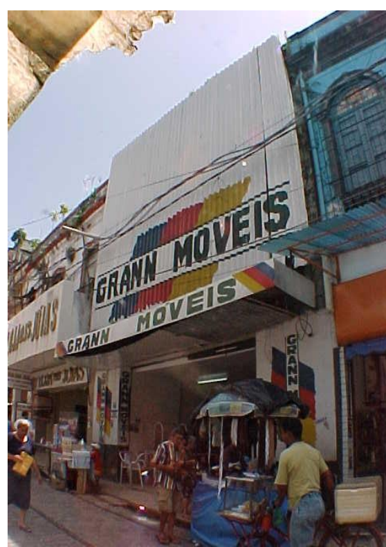
Fig. 89: Vista do imóvel em 2001. Fonte: INBISU-IPHAN, Belém, 2001.
