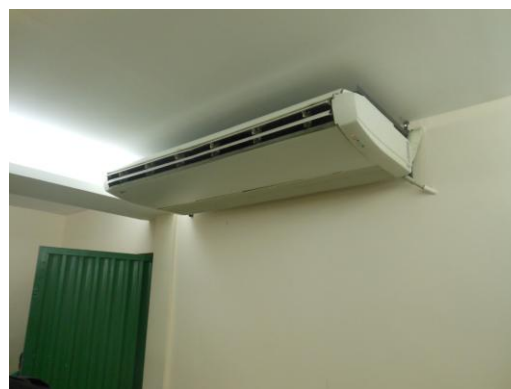
Figura 27 – Condicionador de ar tipo Split e detalhe da sanca. Fonte: a autora.
