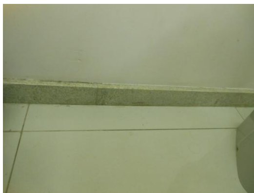
Figura 26 – Detalhe do piso e rodapé. Fonte: a autora.
