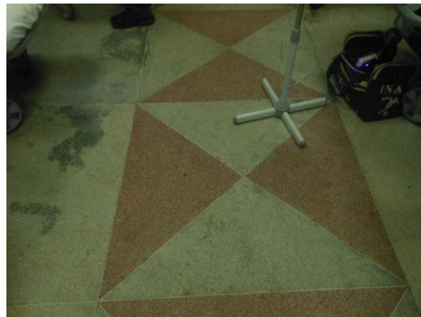
Figura 19 – Piso de alta resistência. Fonte: a autora.
