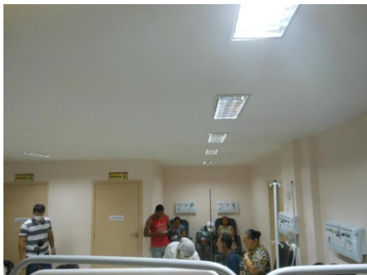
Figura 35 – Detalhe do forro de gesso liso contínuo. Fonte: a autora.
