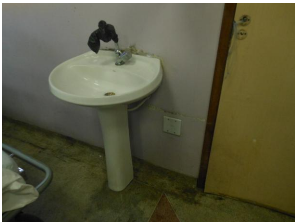
Figura 18 – Lavatório aguardando manutenção Fonte: a autora.
