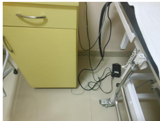
Figura 36 – Detalhe do piso e rodapé. Fonte: a autora.
