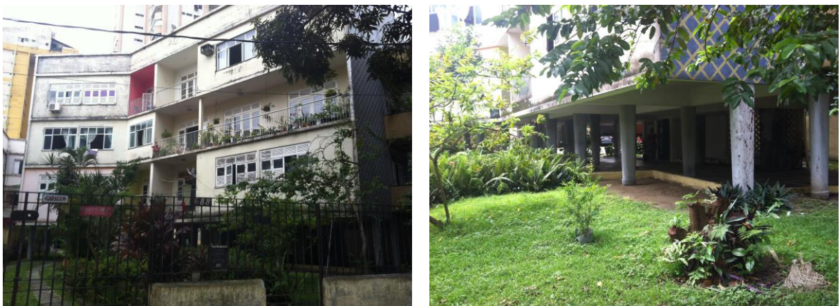
Figura 9: Edifício São Miguel.
