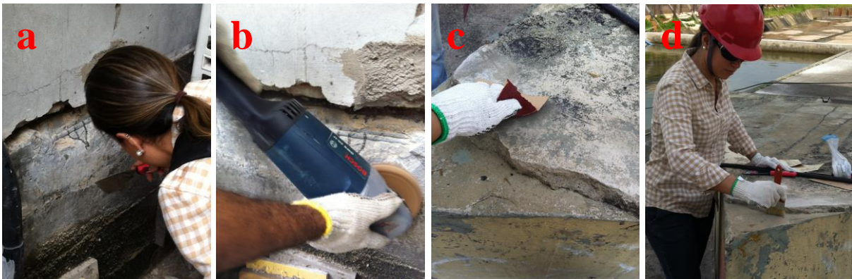
Figura 39: Preparo e limpeza do substrato: (a) remoção das camadas de resina de proteção do concreto; (b) lixamento com lixadeira elétrica; (c) lixamento com lixa d'água; (d) limpeza com auxílio de pincel.
