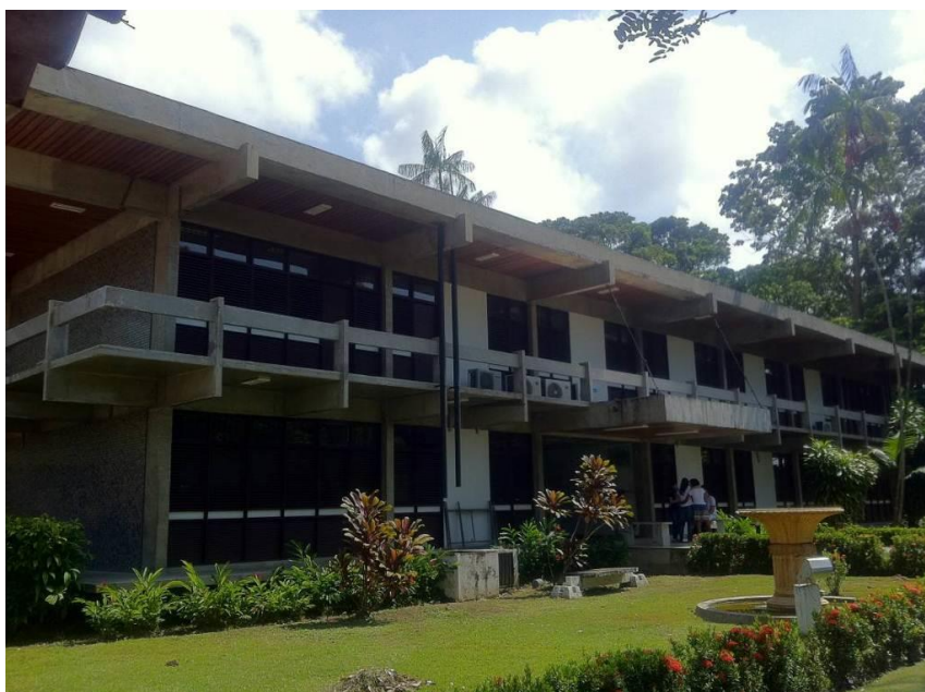
Figura 27: Edifício da Faculdade de Arquitetura e Urbanismo - UFPa.
