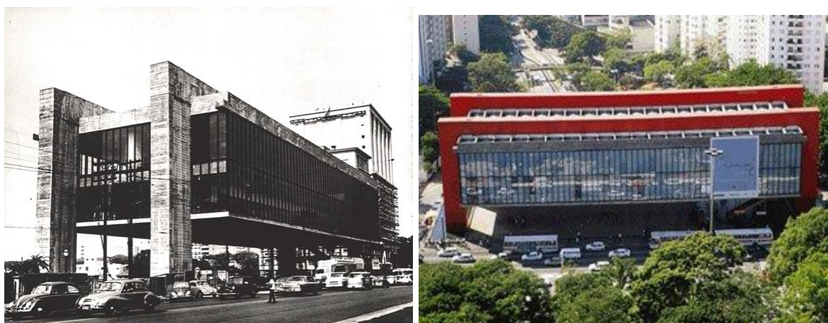
Figura 3: MASP antes e depois de receber a pintura nas vigas e pilares.
