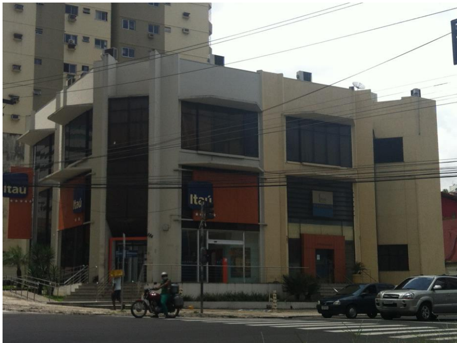
Figura 19: Edifício do Banco Itaú.
