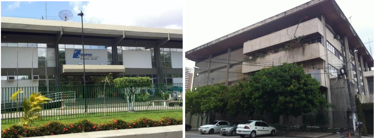
Figura 12: Edifício do Serviço Federal de Processamento de Dados – SERPRO e da Secretaria de Meio Ambiente – SEMA.
