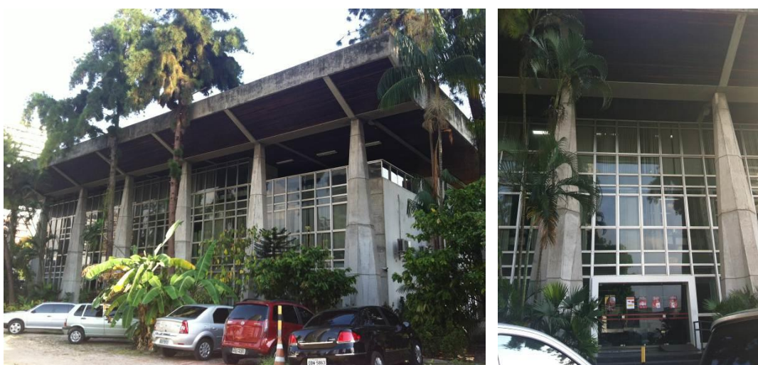
Figura 11: Edifício da Promotoria da República projetado pelo engenheiro e arquiteto Alcyr Meira na década de 1960.
