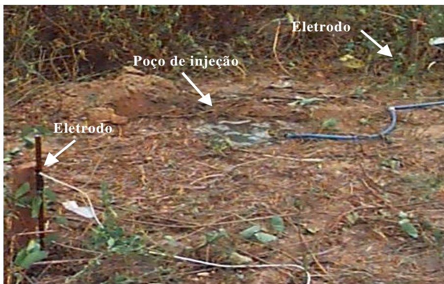
Figura 7: Poço utilizado para a injeção de solução salina.
