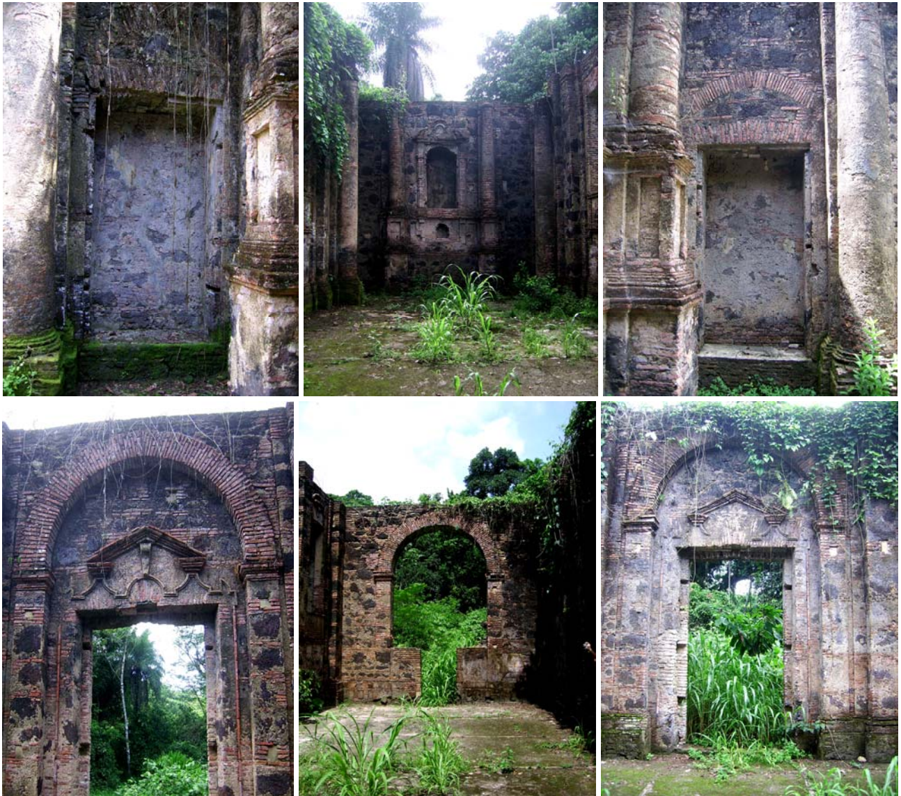
Figura 2.5 – Vistas internas das ruínas da Capela de Nossa Senhora da Conceição (Fotos realizadas em 16/10/2006).
