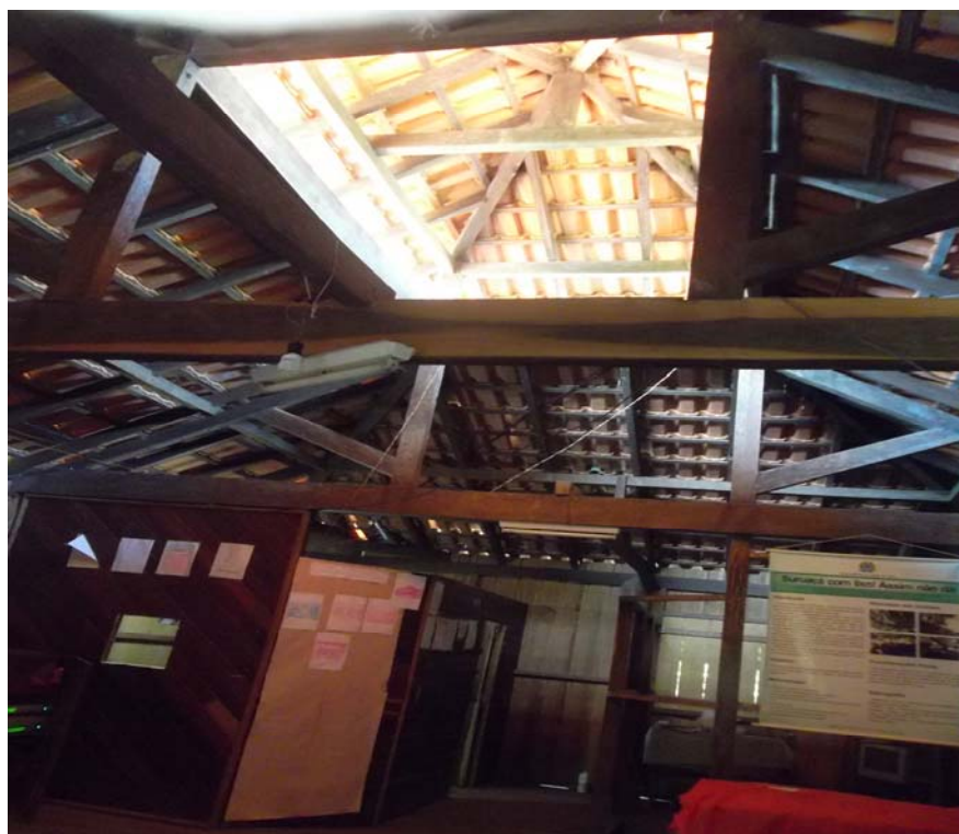
Estrutura do Telecentro toda em madeira
