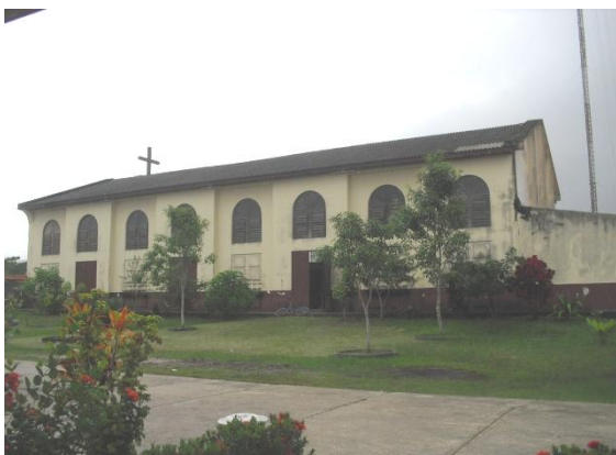
Imagem 14: Visão lateral da Igreja N. S. do P. Socorro
