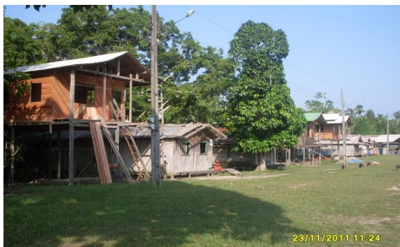
Imagem 20: Casas com novas estruturas na Comunidade São Pedro 57
