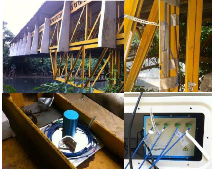
Figura 41 – Ponte de pedestres e exemplos de sensores instalados.
