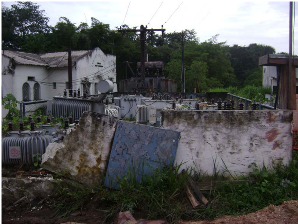
Figura 6. 5 – Subestação de energia elétrica na área do Parque Estadual do Utinga.
