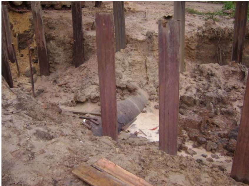
Figura 6. 4 – Escavação da adutora de aço de 1000 mm na área da COSANPA no Parque Estadual do Utinga.
