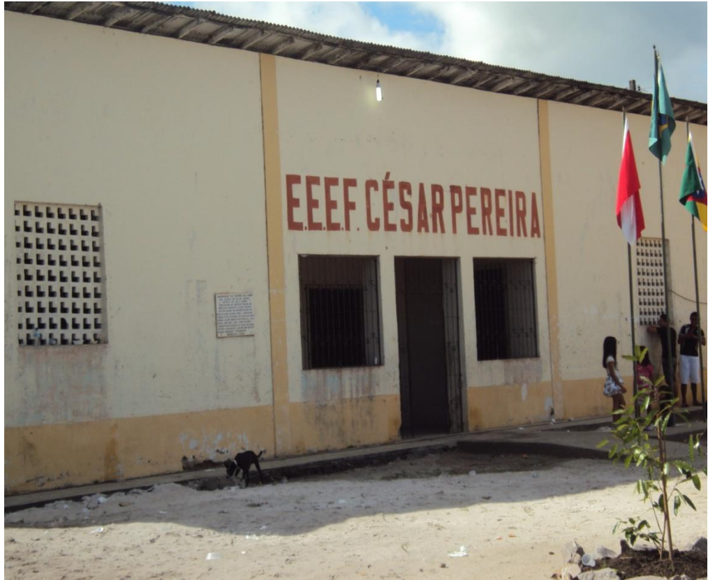
Figura 13: E. E. F. César Pereira prédio atual
