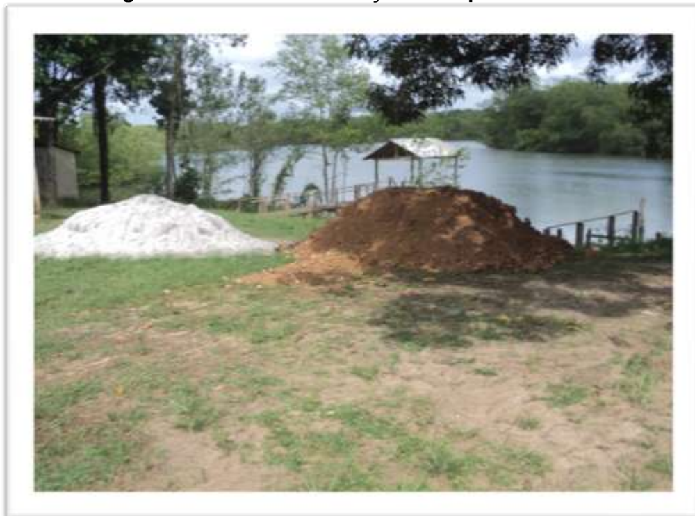
Figura 19: Local da construção do trapiche
