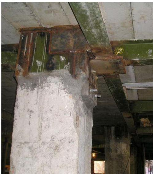
Figura 3.21 – Exemplo de reforço com colarinho e berço metálico em pilar de concreto
