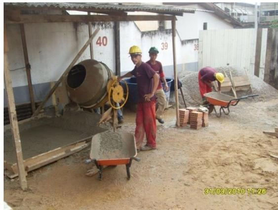
Figura 4.7 – Preparação do concreto com traço 1:2:3 para ( $f_{ck}$ ) de 25 MPa (SEOP – AC)
