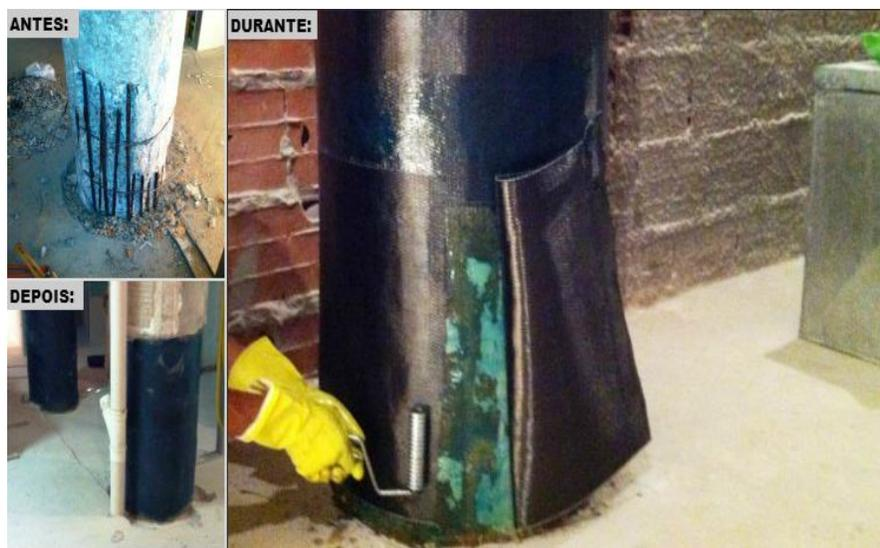
Figura 3.31 – Exemplo de reforço com compósitos de fibra de carbono Sika Wrap® - pilar hospital São Camilo (site: [www.reforcoengenharia.com.br](http://www.reforcoengenharia.com.br))
