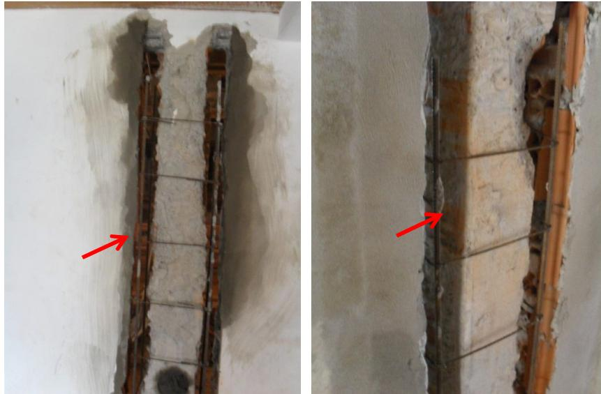
Figura 4.10 – Armação de Ø 12,5 mm com estribo Ø 5,0 mm, reforço dos pilares (SEOP – AC)
