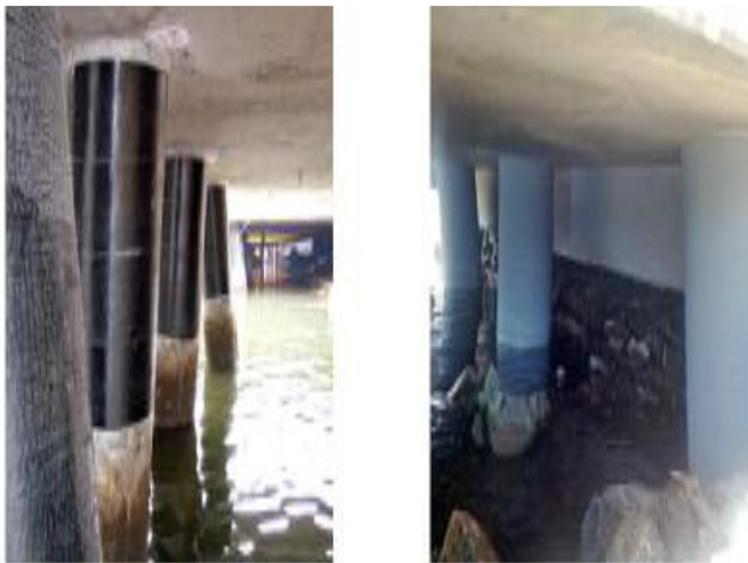
Figura 3.30 – Reforço do atracadouro que interliga a cidade de Santos a Guarujá (site: [www.mc-bauchemie.com.br](http://www.mc-bauchemie.com.br))
