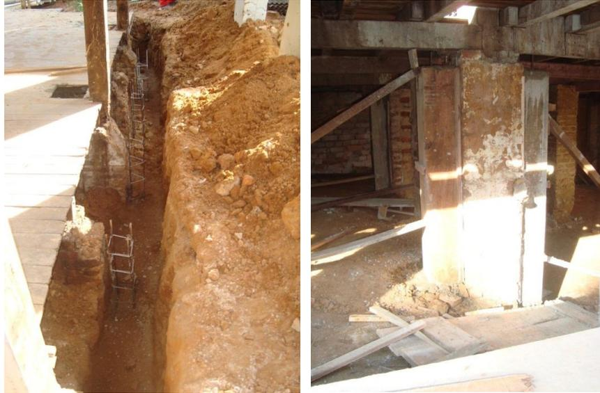
Figura 4.14 – Reforço dos pilares no subsolo concreto armado ( $f_{ck}$ ) de 25 MPa (SEOP – AC)
