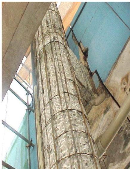
Figura 3.8 - Instalação de armadura adicional de recuperação e reforço em pilares de apoio das rampas monumentais maracanã (Jordy, 2002)
