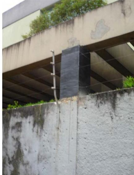
Figura 3.22 – Reforço fibra de carbono ([www.tecnologiademateriais.com.br](http://www.tecnologiademateriais.com.br))
