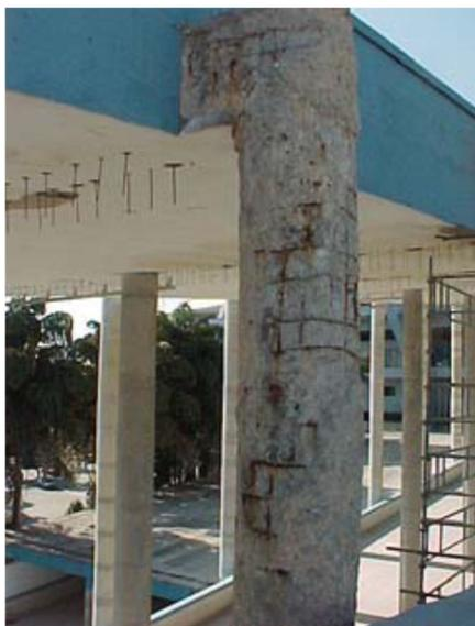
Figura 3.6 - Deterioração na estrutura de pilar de apoio das rampas monumentais maracanã (Jordy, 2002)
