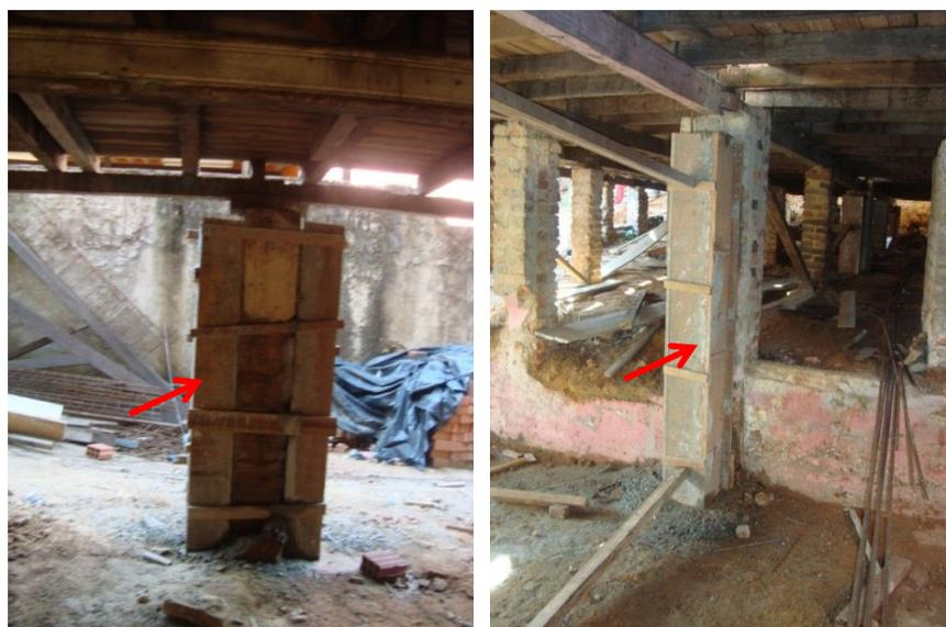
Figura 4.13 – Reforço dos pilares no subsolo concreto armado ( $f_{ck}$ ) de 25 MPa (SEOP – AC)
