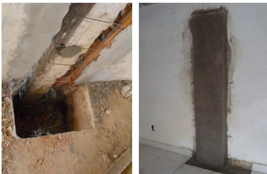
Figura 4.12 – Reforço dos pilares concreto armado ( $f_{ck}$  25 MPa (SEOP – AC)
