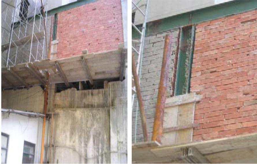
Figura 3.19 – Vista do prolongamento do pilar de concreto com pilar metálico na obra do TRT (Campos, 2006)
