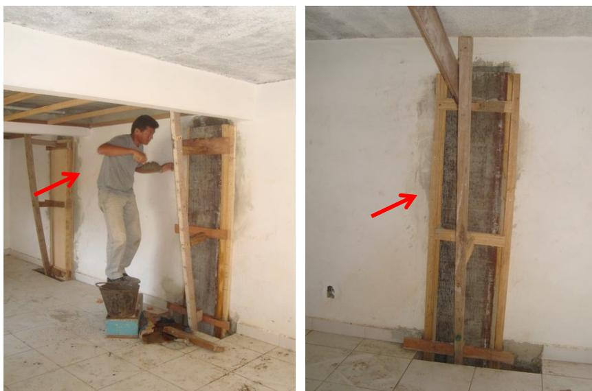
Figura 4.11 – Aplicação de *grout* e concreto no reforço dos pilares (SEOP – AC)
