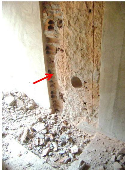
Figura 4.5 – Vista do pilar “caco de tijolo” substituição à brita (SEOP – AC)
