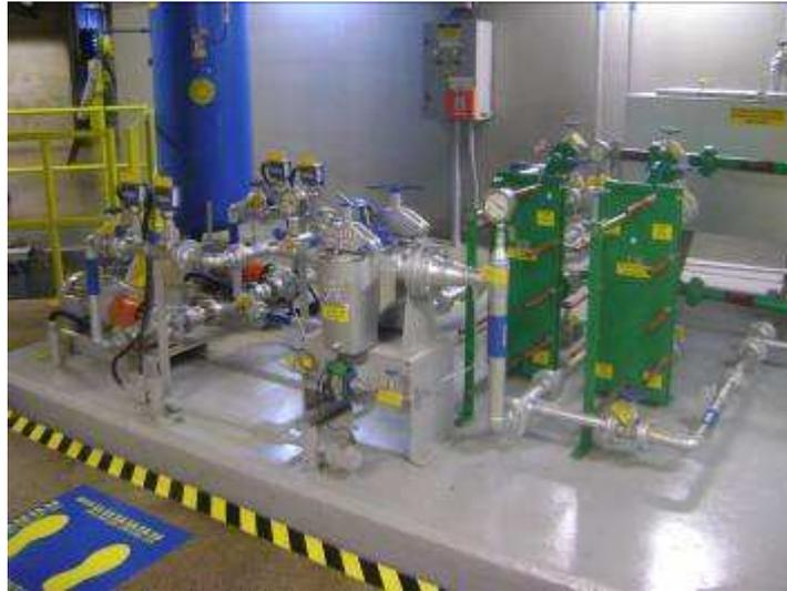
Figura 24 - Foto do arranjo do Sistema de Circulação de Óleo do Mancal Guia do Gerador
