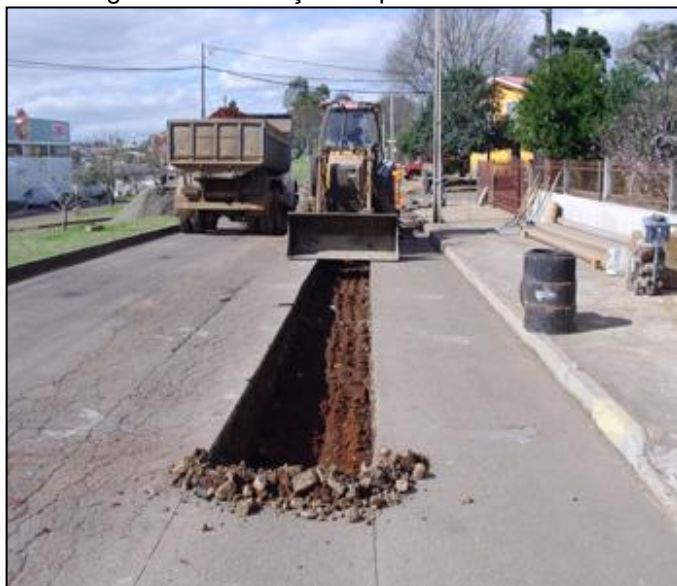
Figura 22 - Remoção do pavimento asfáltico
