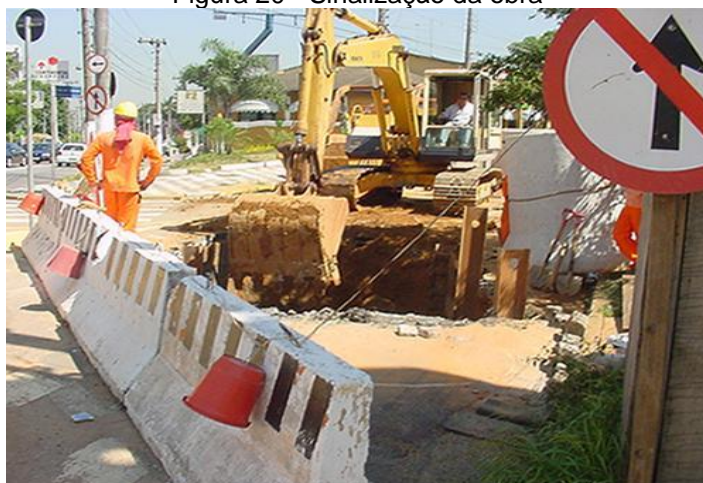
Figura 20 - Sinalização da obra
