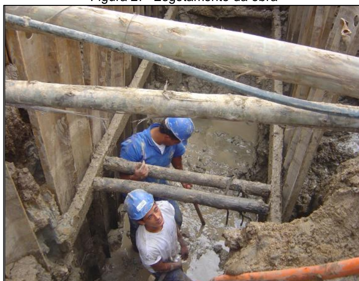
Figura 27- Esgotamento da obra
