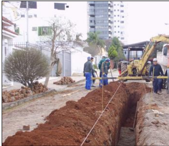
Figura 23 - Utilização da retroescavadeira
