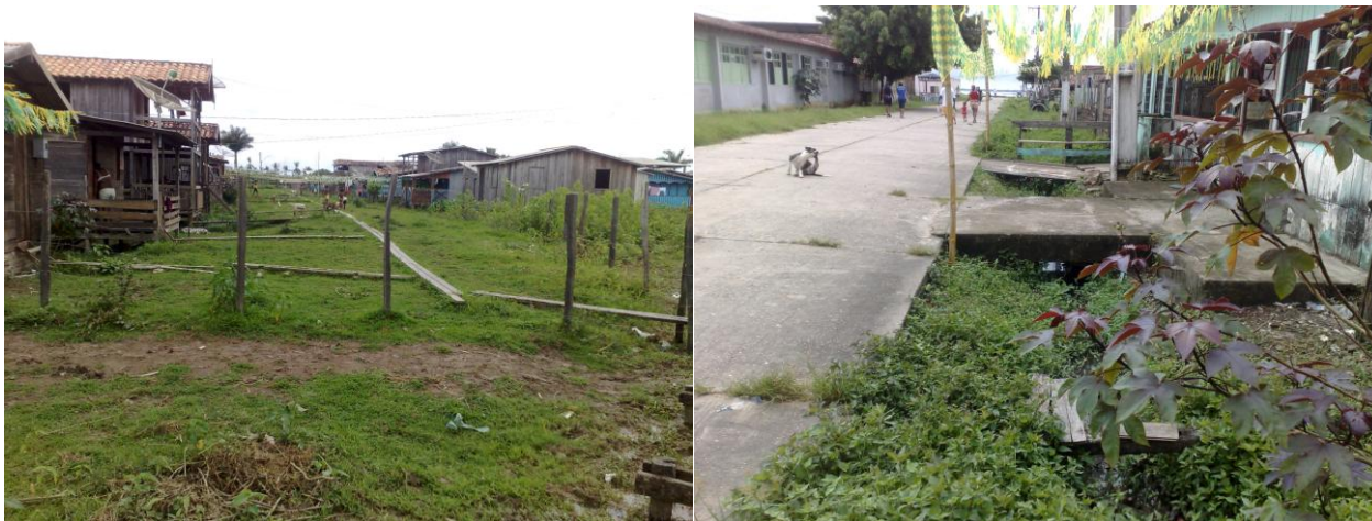
Figura 34 – Ruas sem saneamento
