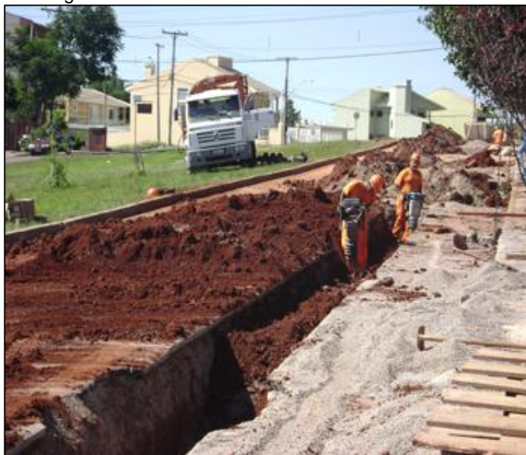
Figura 32 - Reaterro Manual com socador mecânico
