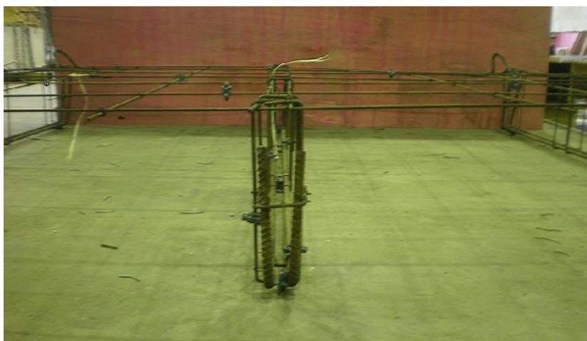
**Figura 3.13** – Destaque da armadura da nervura central da laje nervurada
