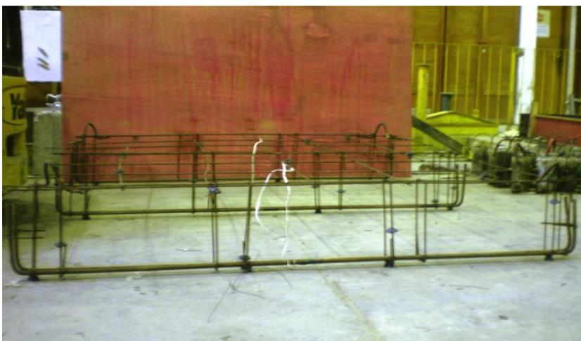
**Figura 3.12** – Armadura da laje nervurada
