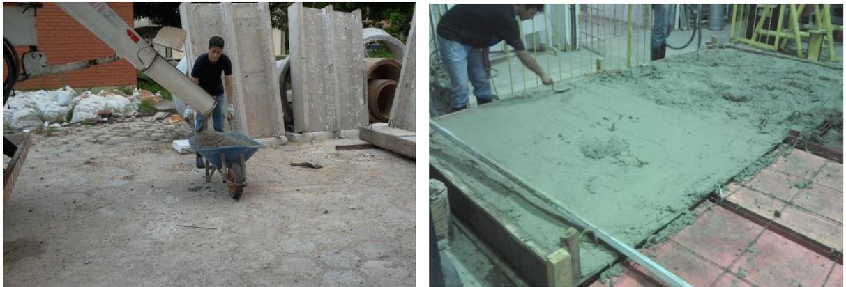
**Figura 3.16** – Transporte, concretagem, vibração do concreto e regularização da superfície das lajes
