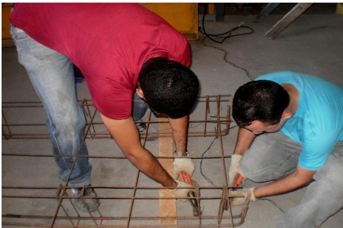
**Figura 3.11** – Montagem da armadura da laje nervurada
