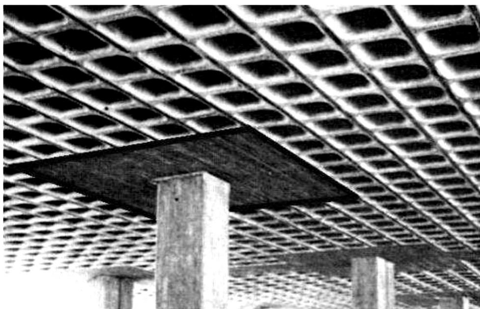
**Figura 2.5** – Laje nervurada apoiada diretamente em pilares (TESORO, 1991)
