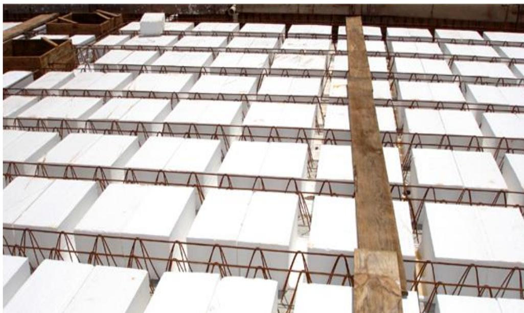
**Figura 2.1** – Laje nervuradas com a colocação de EPS (<http://www.isoares.com.br/produtos>)
