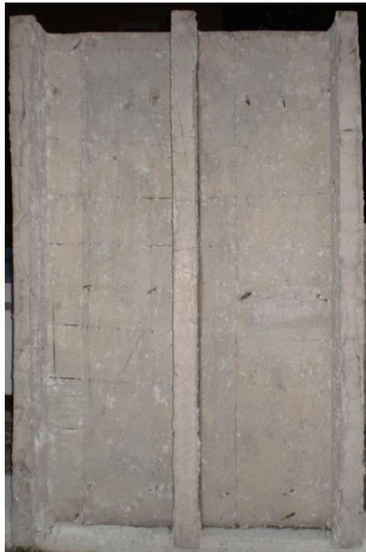
**Figura 3.17** – Laje nervura após desfôrma e retirada das folhas de EPS
