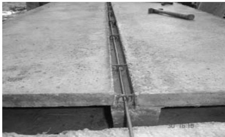
**Figura 2.20** – Detalhe da ligação dos elementos da laje nervura pré-moldada (PEIXOTO & MELO, 2006).
