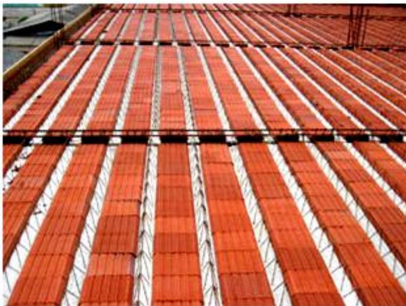
**Figura 1.2** – Laje nervurada pré-moldada unidirecional
