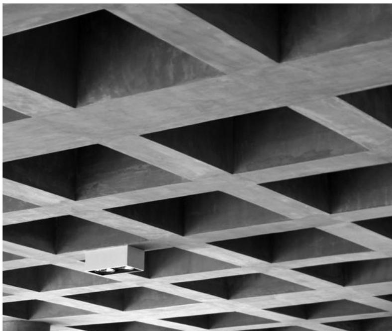
**Figura 1.1** – Lajes nervuradas convencionais
