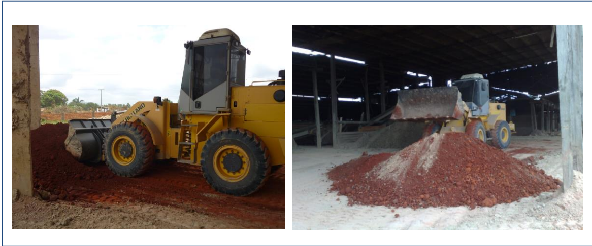
Figura 3.3 – Mistura dos materiais com a pá mecânica
