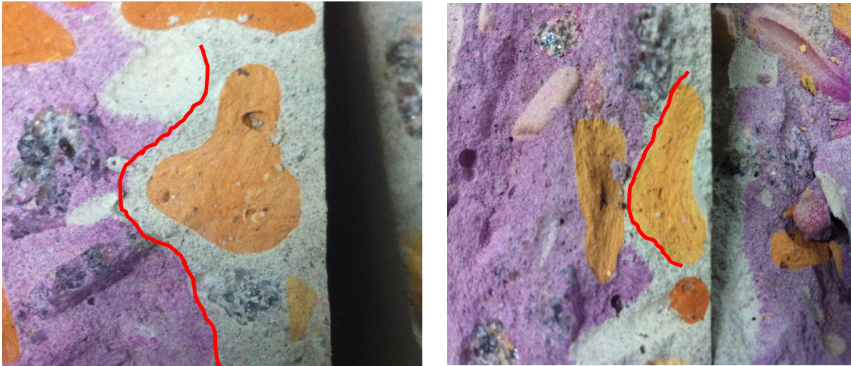
FIGURA 27 - AVANÇO DA FRENTE DE CARBONATAÇÃO ATRAVÉS DE AGREGADOS DE ORIGEM CERÂMICA.
